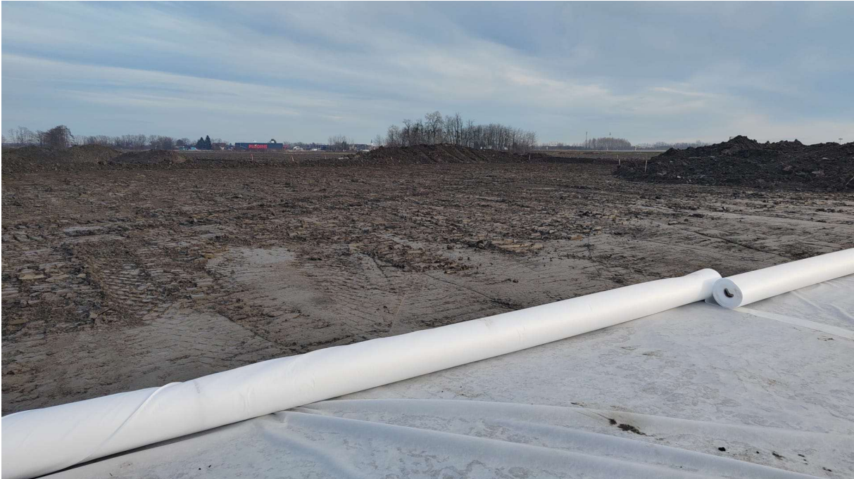
Slika 7: Postavljanje geotekstila na temeljno tlo
