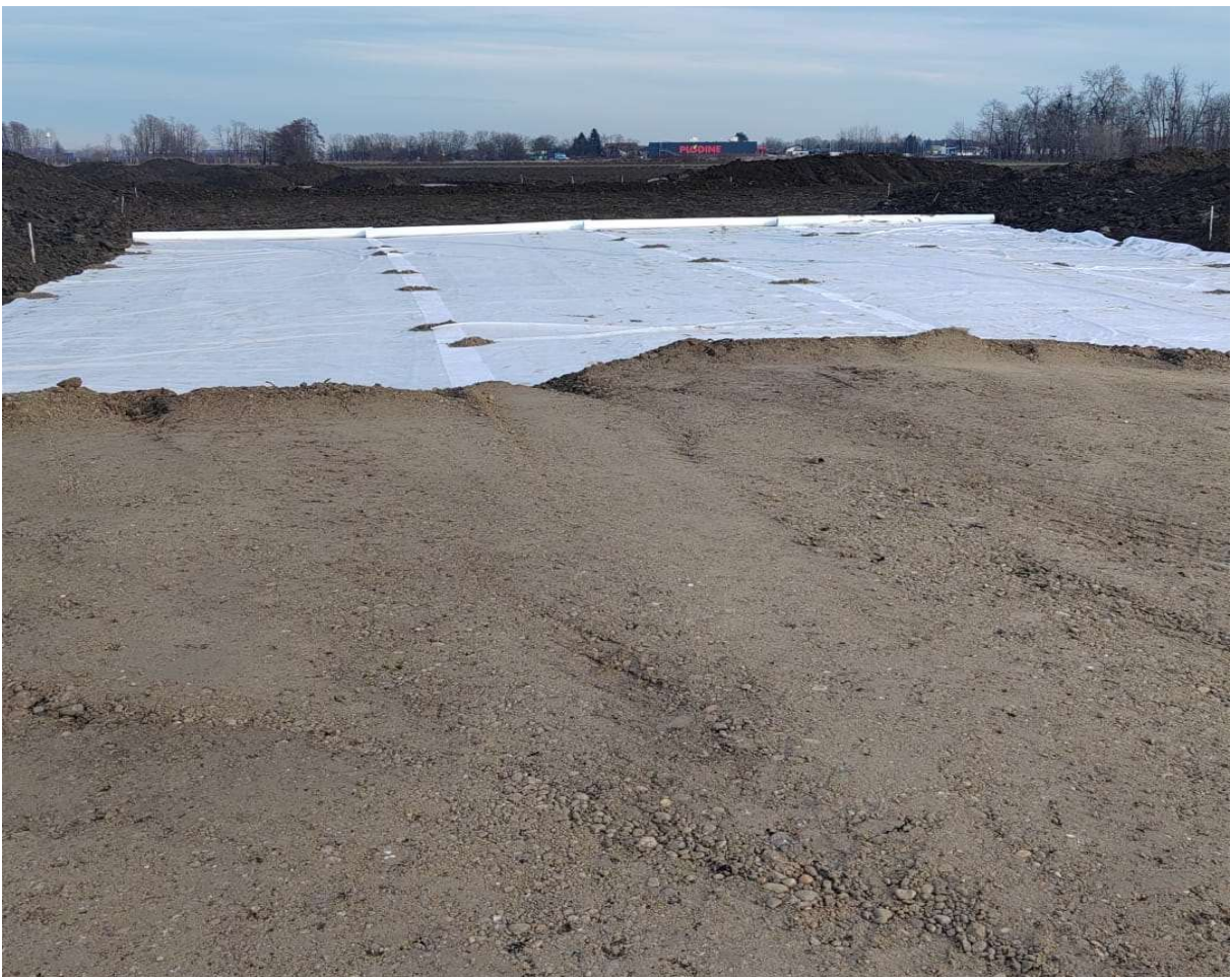
Slika 8: Nasipavanje prvog sloja nasipa
