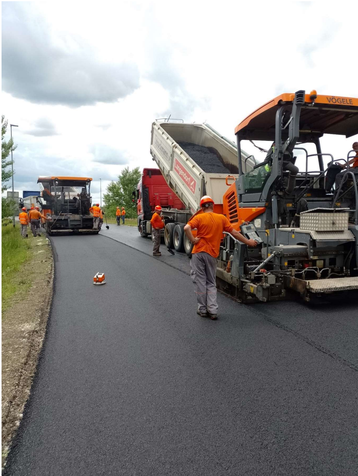
Slika 23: Ugradnja asfalta i ispitivanje stupnja zbijenosti nerazornom metodom uređajem PQI
