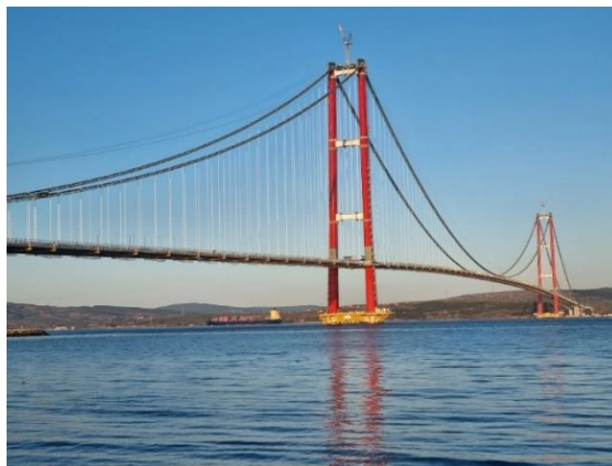
Slika 38.: Most sa rekordnim rasponom od 2023 m između glavnih stupova (Izvor: dezeen, Lizzie Crook, 2022.)
