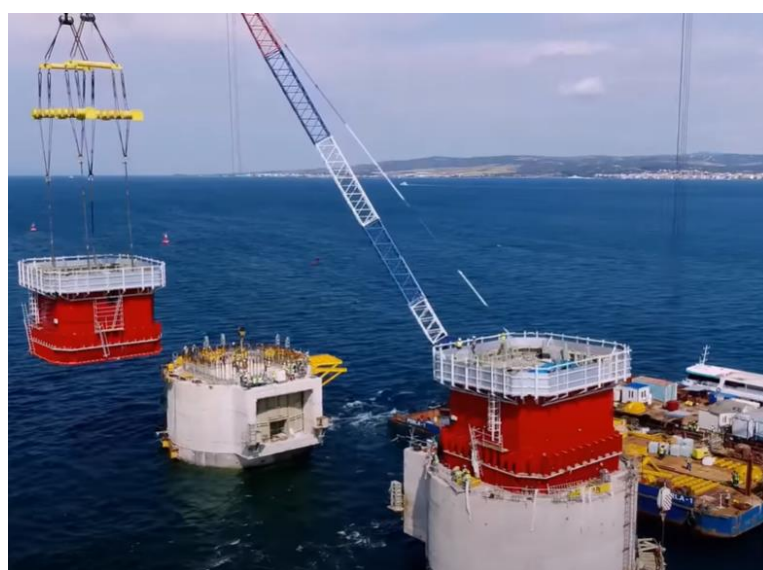
Slika 41.: Montaža prvih segmenata karakteristične crvene boje
