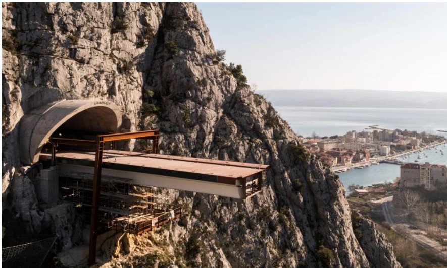
Slika 18.: Pogled iz zraka na kanjon rijeke Cetine
