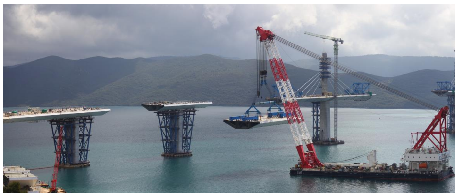
Slika 34.: Transport prilaznih segmenata sa plovnom dizalicom koji se oslanjaju na stupove i pomoćne skele
