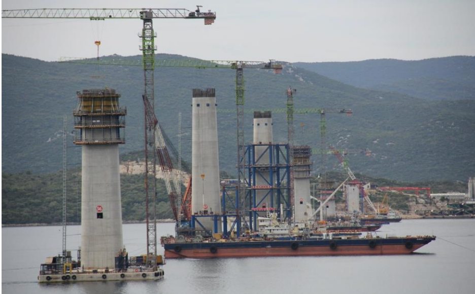
Slika 32.: Gradnja AB pilona pomoću klizne oplata
