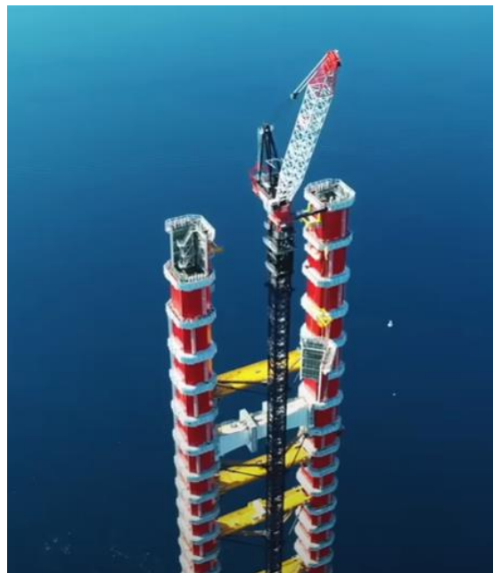
Slika 46.: Dizalica za montažu čeličnog stupa, čija visina je bila i do 300 m
