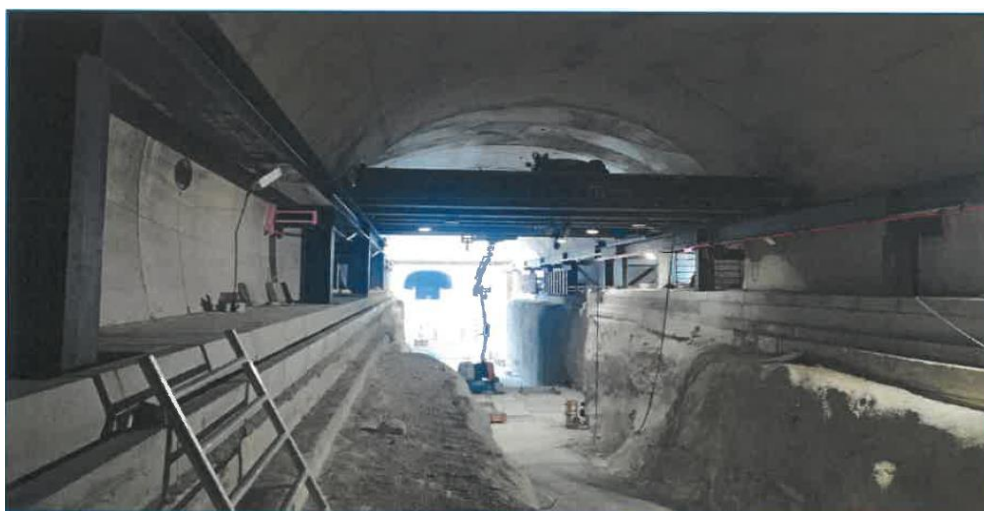
Slika 19.: Prostor za montažu čeličnih elemenata unutar tunela
