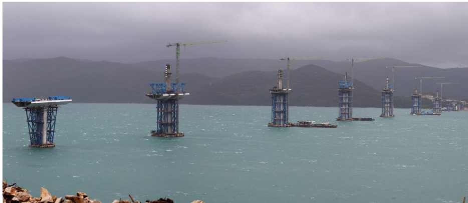
Slika 29.: Naleti vjetra od oko 160 km/h mogu predstavljati problem za gradnju mosta
