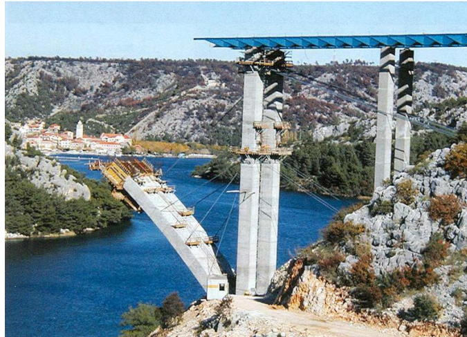
Slika 2.: Prikaz gradnje mosta preko Krke kod Skradina (Izvor: Građevinar, most preko rijeke Krke kod Skradina, 2003)
