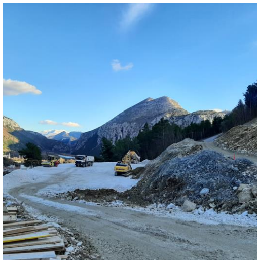
Slika 26.: Radovi na obilaznim i pristupnim cestama
