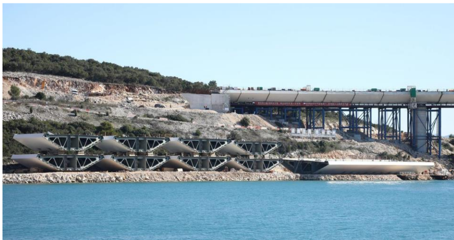
Slika 36.: Skladištenje čeličnih montažnih elemenata na obali
