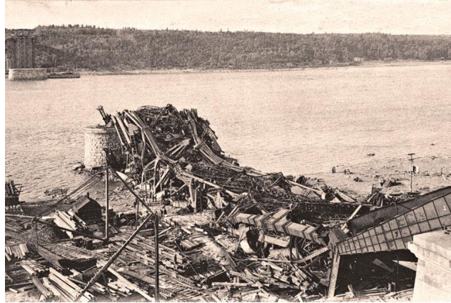
Slika 6.: Urušena struktura mosta u Kanadi, koja je nastala zbog nepravilnog projektiranja nosivih skela (Izvor: Canada's history, 2017.)
