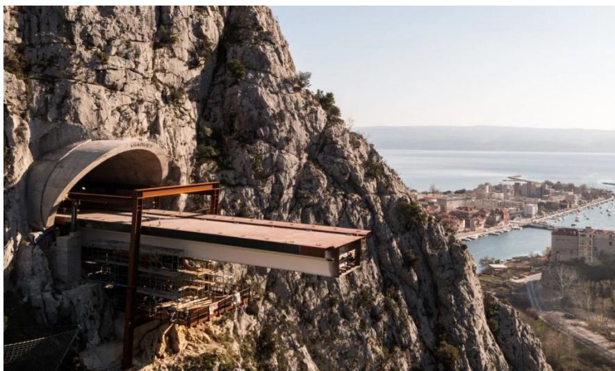
Slika 18.: Pogled iz zraka na kanjon rijeke Cetine
