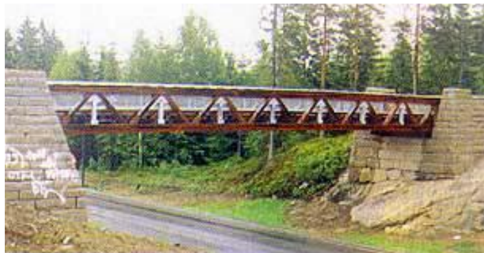
Slika 7.: Nesoddvegen most, drveni pješački nadvožnjak (Izvor: Nov pristup građenju drvenih mostova 2002.)
