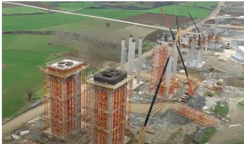
Slika 44.: Gradnja stupova pristupnog vijadukta gdje se vidi korištenje puno oplata, skela i dizalica
