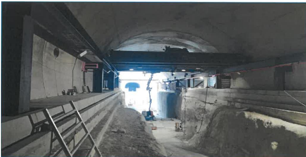
Slika 19.: Prostor za montažu čeličnih elemenata unutar tunela
