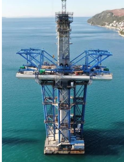
Slika 35.: Gradnja prvih glavnih segmenata oko pilona
