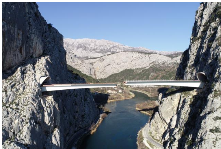
Slika 25.: Pogled sa strane na most i njegovu okolinu
