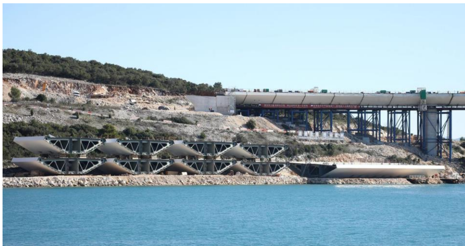
Slika 36.: Skladištenje čeličnih montažnih elemenata na obali
