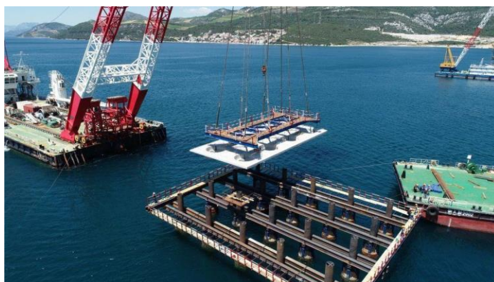
Slika 31.: Postavljanje betonskih ploča za bazu pilona pomoću plovne dizalice
