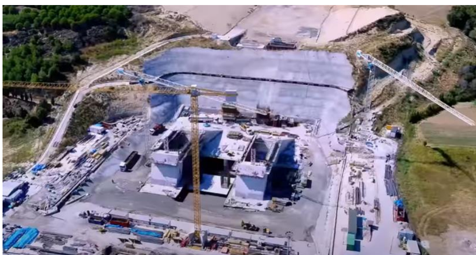
Slika 39.: Gradnja sidrenih blokova na obalama Europe i Azije
