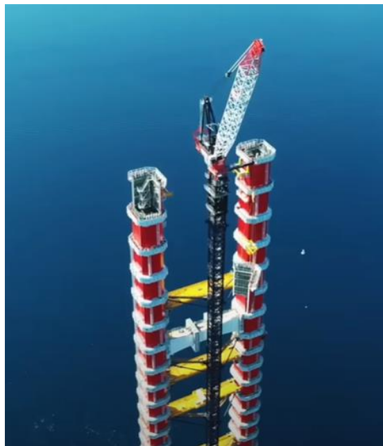
Slika 46.: Dizalica za montažu čeličnog stupa, čija visina je bila i do 300 m
