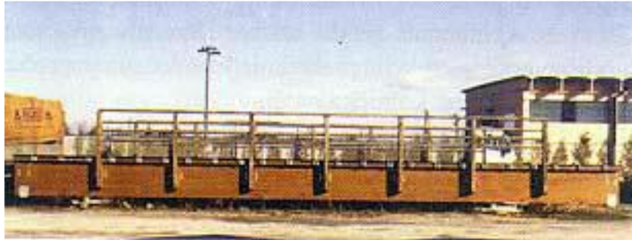
Slika 8.: Most izveden na jednom mjestu, spreman za transport do mjesta ugradnje (Izvor: Nov pristup građenju drvenih mostova 2002.)
