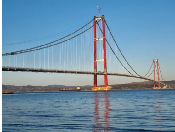
Slika 38.: Most sa rekordnim rasponom od 2023 m između glavnih stupova (Izvor: dezeen, Lizzie Crook, 2022.)
