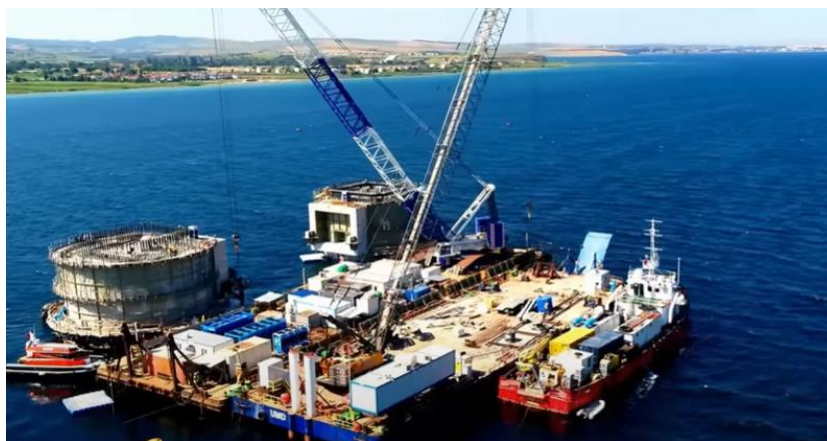
Slika 40.: Postavljanje kesona u more
