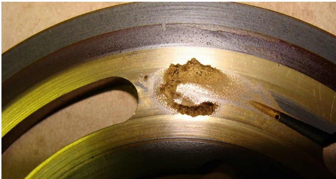
Slika 15.: Oštećenje od kavitacije na ploči ventila [11]
