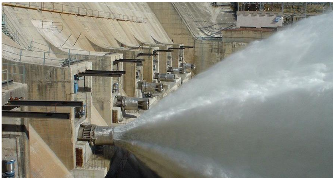
Slika 11.: Ispust kroz Howell-Bunger (konusni) zatvarač [9]
