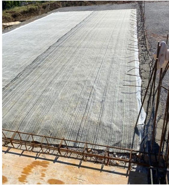
Slika 15. Voltex membrana sa zaštitom
