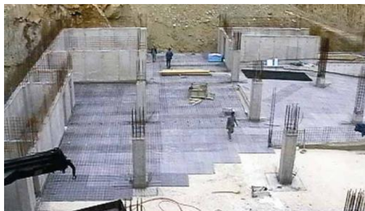
Slika 38. Membrana kao hidroizolacija temeljne ploče
