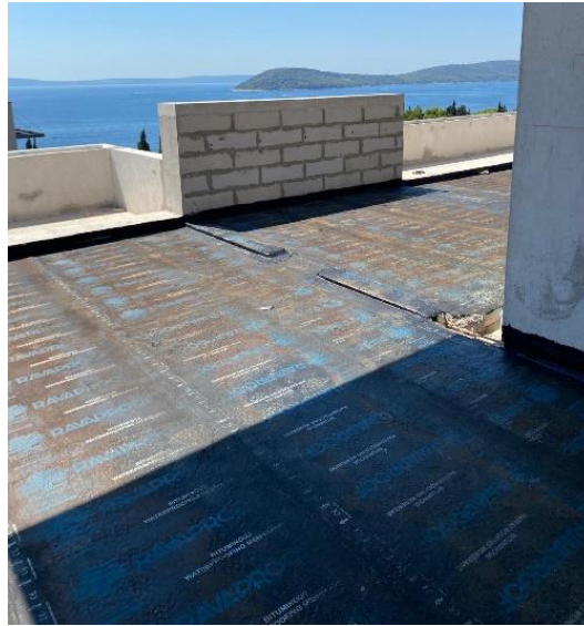
Slika 5. Bitumenska membrana na terasi
