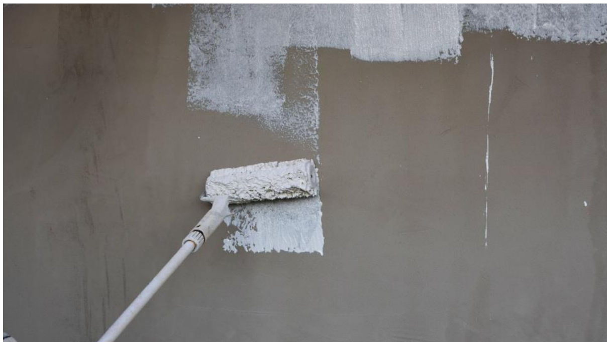
Slika 21. Izvedba zidnog premaza
