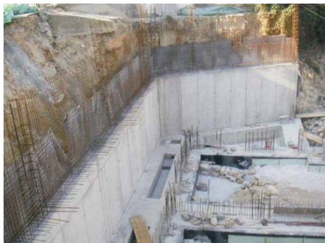
Slika 37. Postavljanje Voltex-a u jednostranu oplatu
