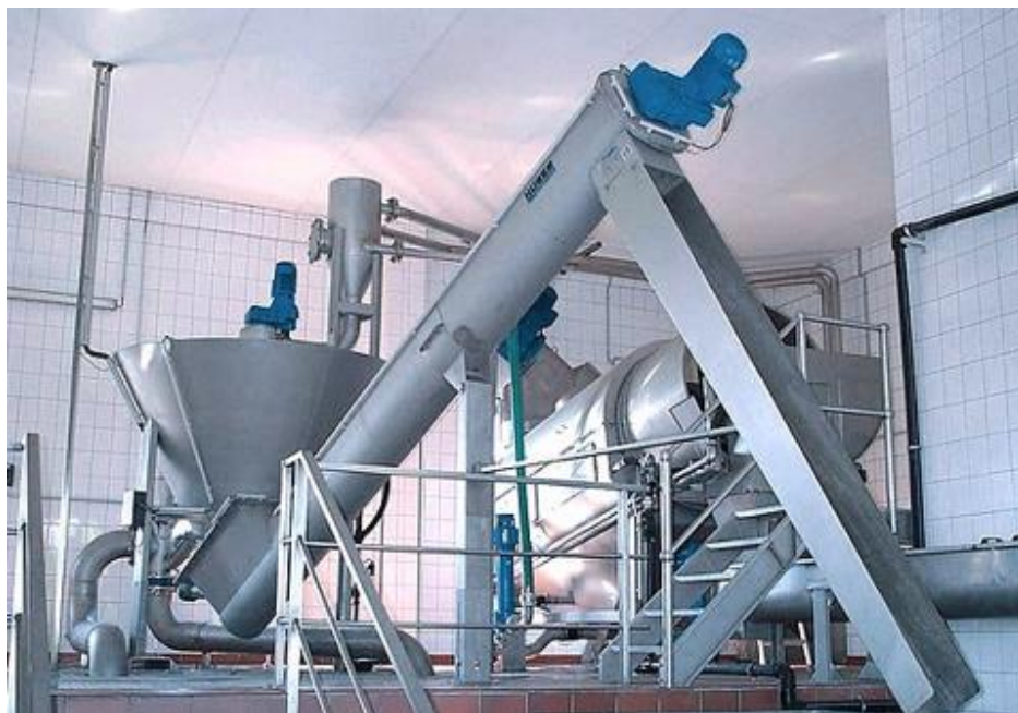
Slika 44: KOANDA uređaj za pranje pijeska H.Huber (Izvor:[5])
