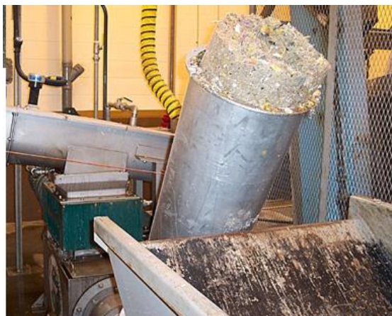
Slika 41: Preša za materijal skinut s rešetki (Izvor:[5])
