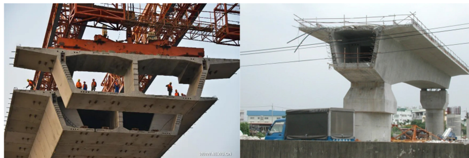
Slika 3: kutijasti gredni nosači [1, 5]
