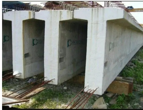
Slika 5: T-gredni nosači [7]
