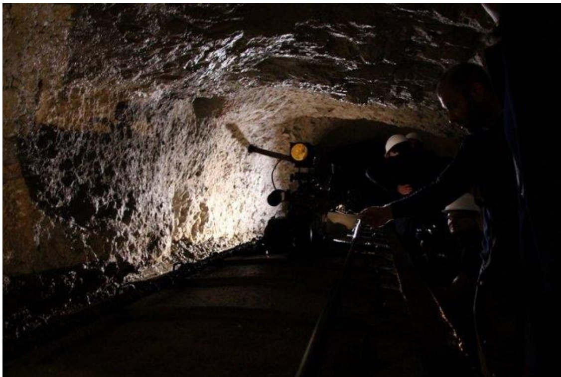
Slika 5.: Hidrotehnički tunel koji je prokopan ispod brda Srđ te izlazi u blizini zgrade Vodovoda Dubrovnik radi daljnje vodoopskrbe cijelog Grada (Izvor: [3])
