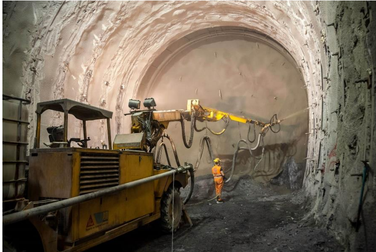
Slika 3.: Strojno nanošenje mlaznog betona (Izvor: [7])
