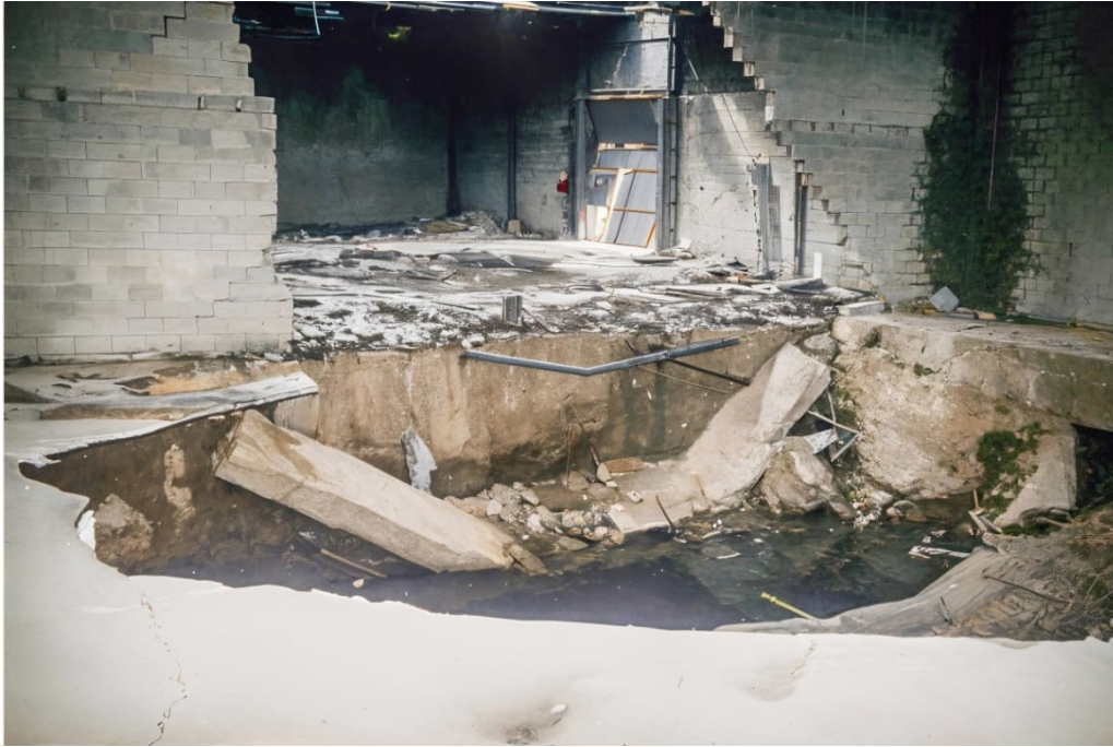
Slika 14 Otvaranje vrtače u tvornici, Zaragoza, Španjolska (Izvor: [5])
