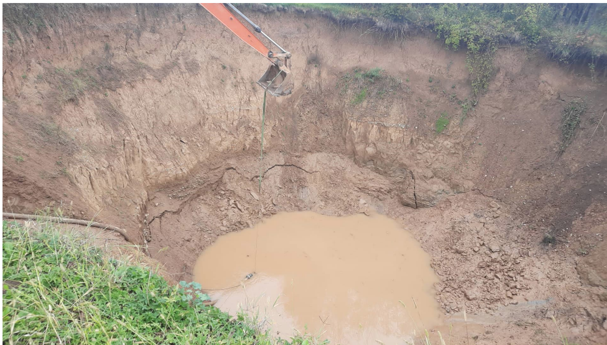
Slika 42 Crpljenje vode iz urušne vrtače S001 - 27.10.2022. (Izvor: [14])
