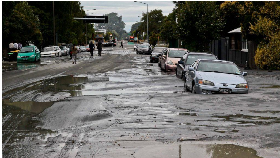
Slika 14. Ilustrativni prikaz pojave likvefakcije u tri karakteristične faze uslijed potresnog opterećenja (Izvor: [14])
