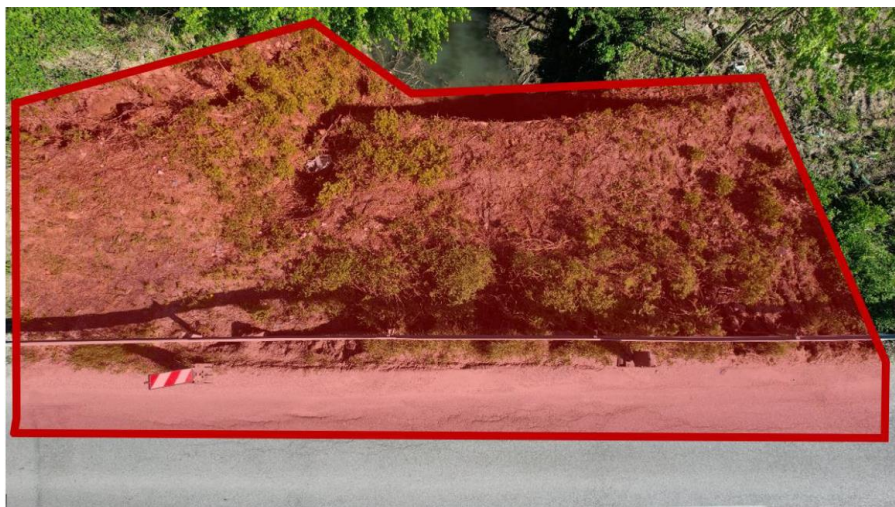
Slika 14.: Zona klizanja (Izvor: [5])
