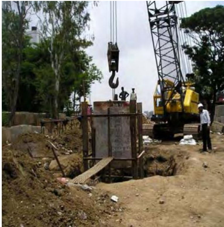
Slika 64.: Provođenje dinamičkog testa nosivosti na terenu (Izvor: [33])
