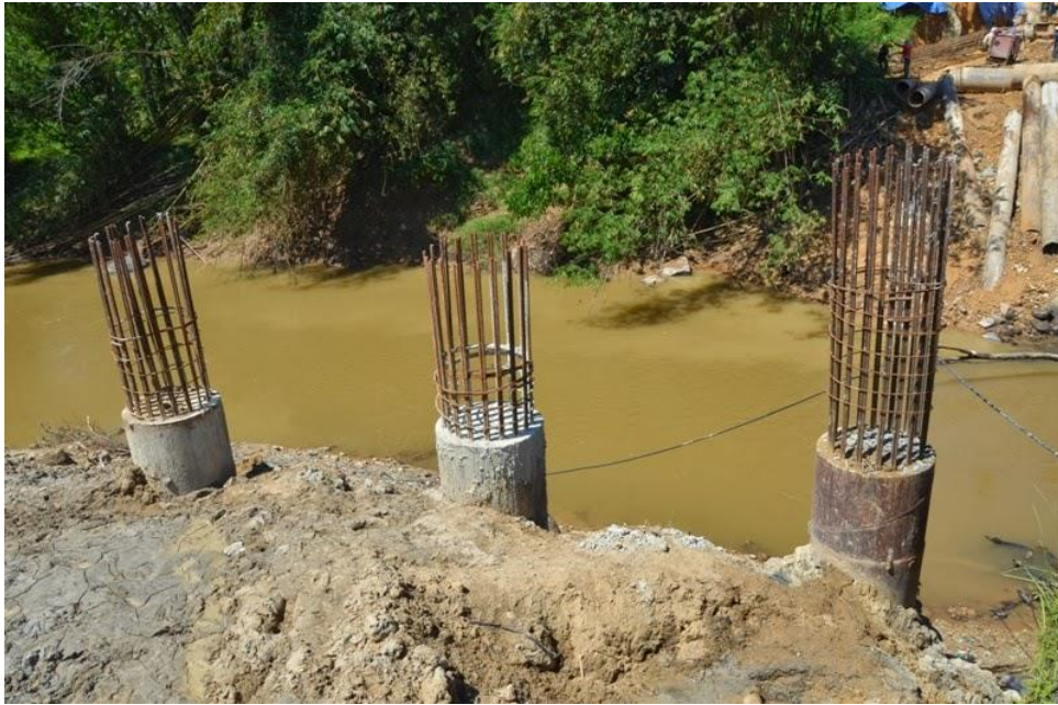
Slika 1.: Uporaba pilota u blizini rijeke (Izvor: [6])
