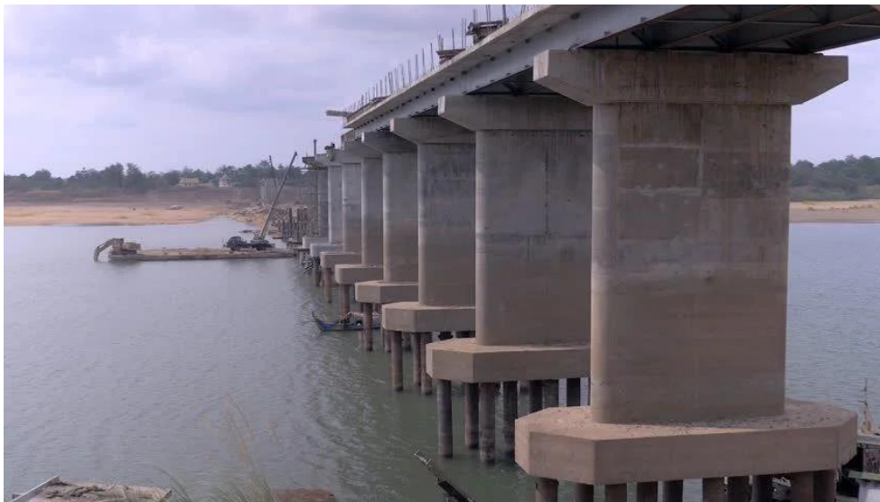
Slika 2.: Temeljenje upornjaka mosta na pilotima (Izvor: [7])
