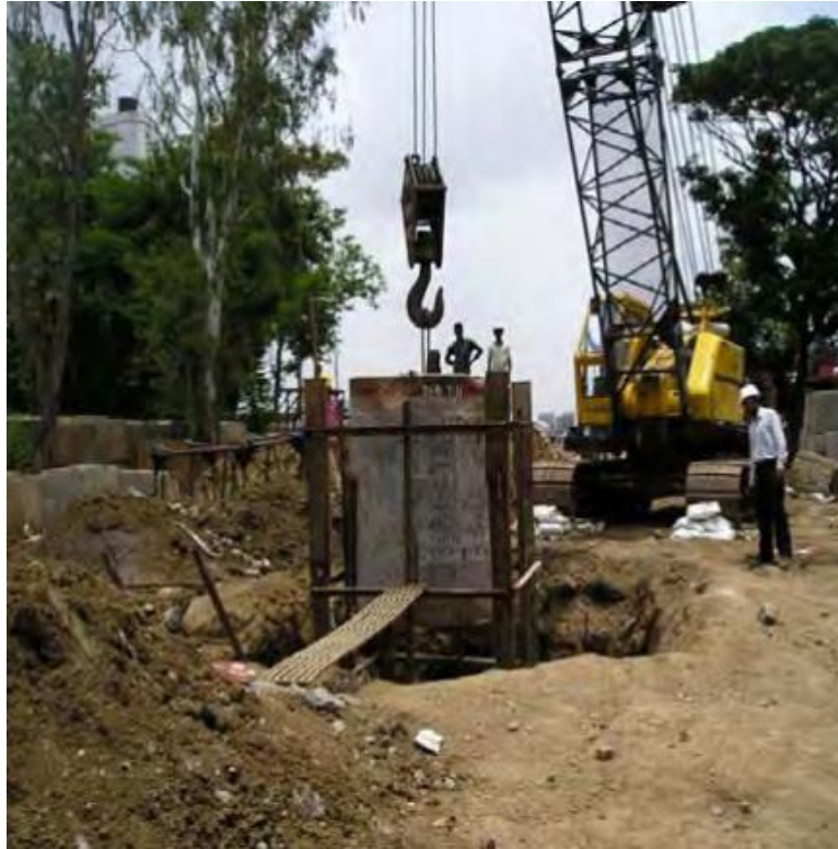
Slika 64.: Provođenje dinamičkog testa nosivosti na terenu (Izvor: [33])
