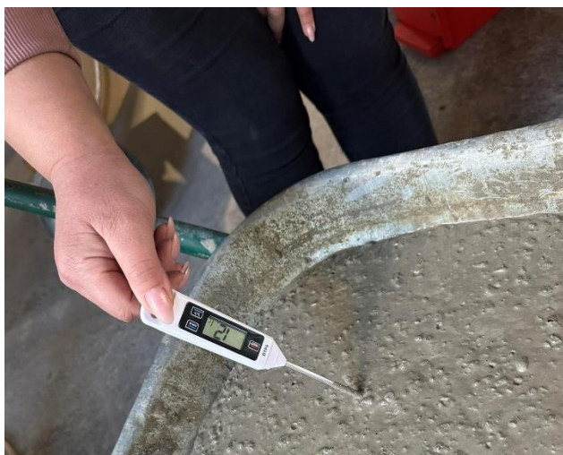
Slika 31. Mjerenje temperature svježeg betona
