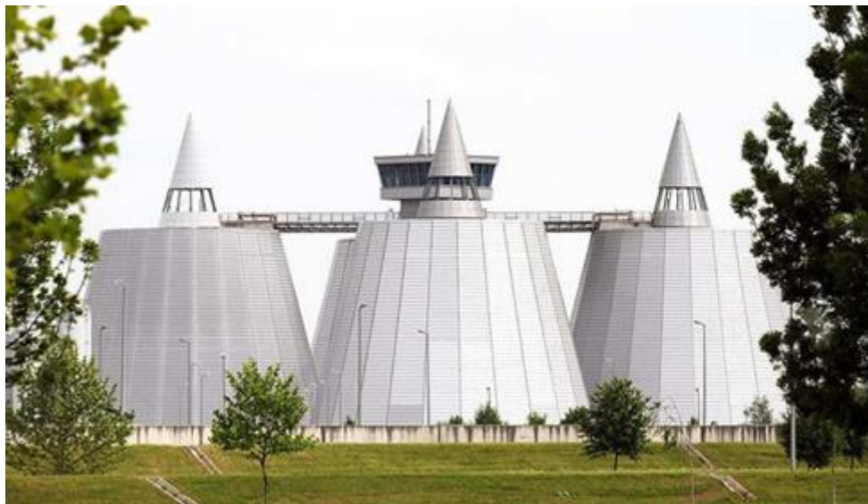
Slika 25. Tornjevi za anaerobnu obradu mulja na UPOV-u u Zagrebu [53]
