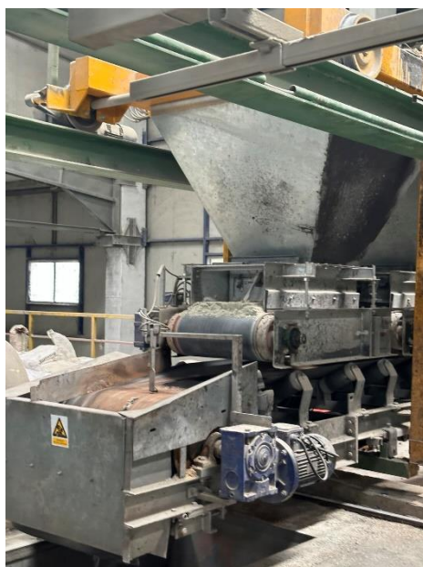
Slika 49. Postrojenje za proizvodnju vibroprešanog betona pogona Beton Lučko d.o.o.
