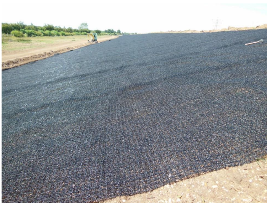
Slika 5 Postavljanje geosintetika na pokos nasipa [5]
