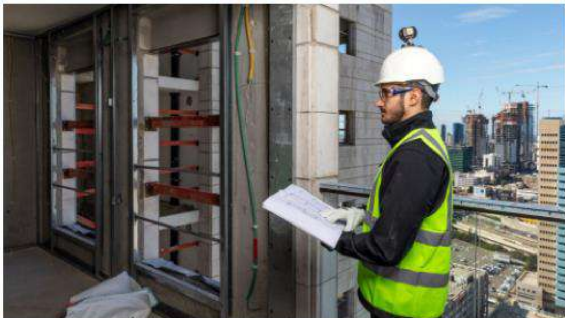
Slika 16: Kamere od 360 stupnjeva za praćenje napretka radova (Izvor: (Fleisher, 2023))
