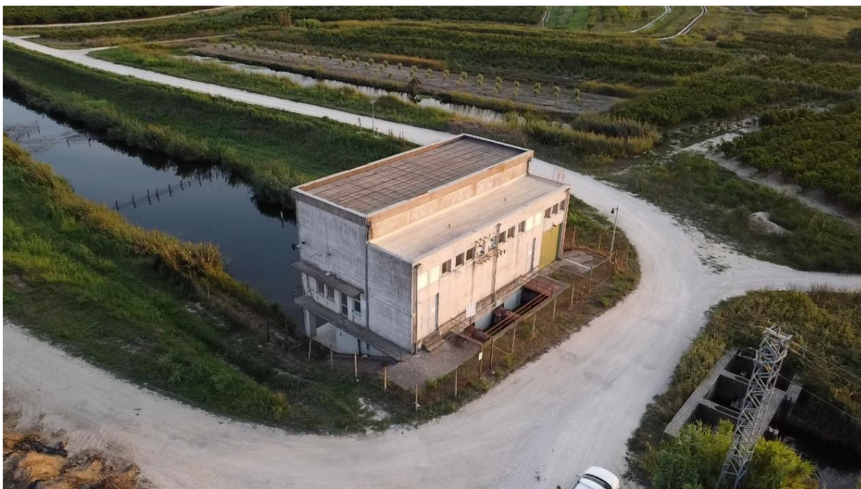
Slika 41: Crpna stanica Prag
