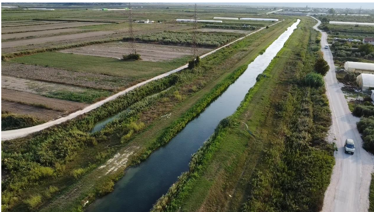
Slika 30: Dio glavnoga dovodnog kanala prema Maloj Neretvi
