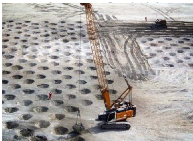
Slika 52. Primjer izvedenog dinamičkog zbijanja u prostoru [25]
