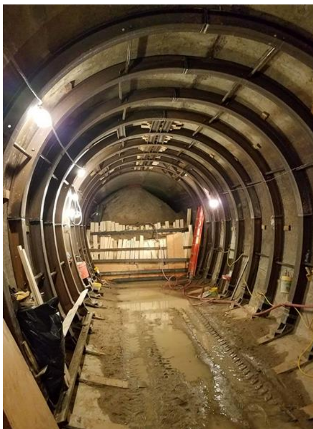
Slika 17. Rebrasti potporni sustav s čeličnim rebrima [61]
