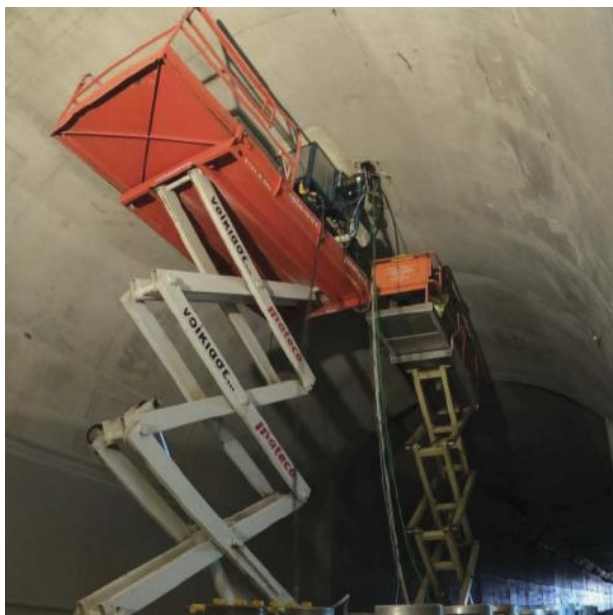
Slika 30. Pozicija nanošenja morta te mjerenja temperature termočlancima [84]
