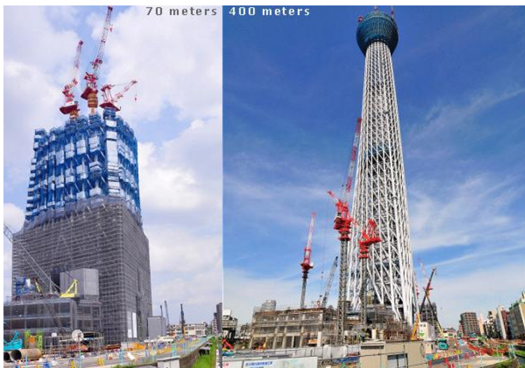
Slika 11.: Postavljanje čelične mreže oko jezgre (Izvor: [16])
