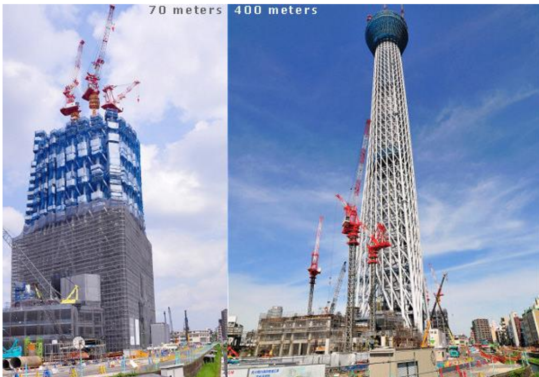
Slika 11.: Postavljanje čelične mreže oko jezgre (Izvor: [16])
