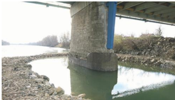
Slika 2. Sanacija temelja stupa mosta zbog podlokavanja
