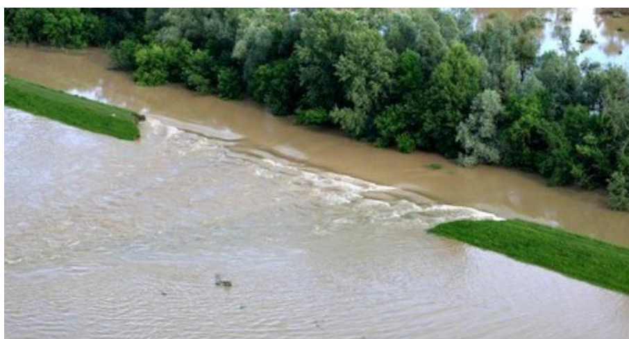
Slika 6: Pucanje nasipa kod Rajeva Sela [14]
