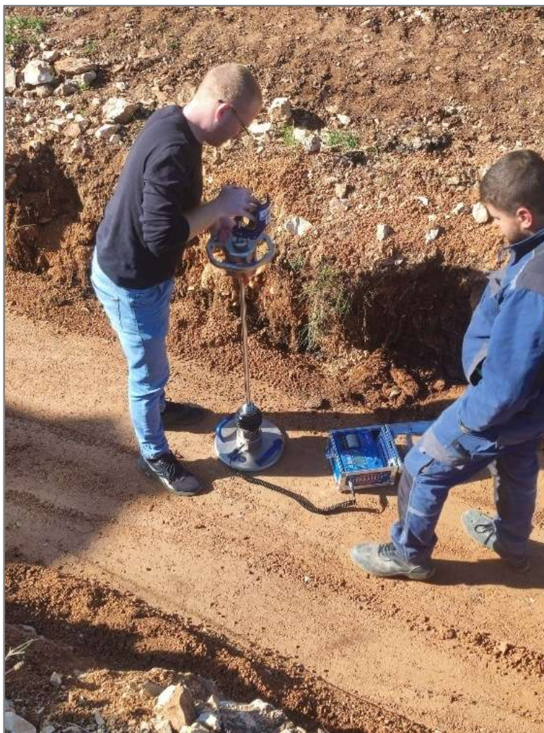
Slika 14: Provođenje testa zbijenosti obloge cijevi pomoću dinamičke ploče (Izvor: autor)
