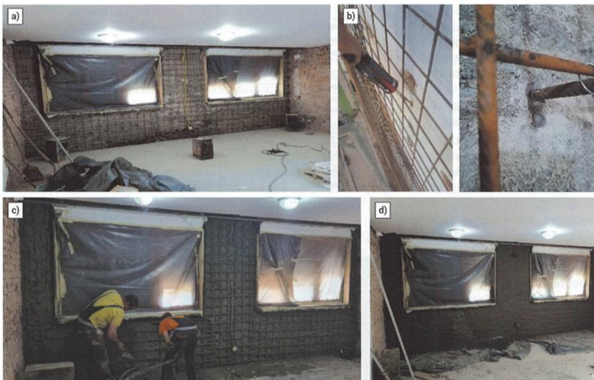
Slika 52 Pojačanje zida torkretiranjem: a) postavljena armatura; b) sidrenje i povezivanje mrežom; c) prvi sloj torkreta; d) drugi sloj torkreta [10]
