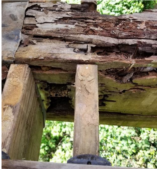
Slika 21.: Truljenje drva (Izvor: [9])
