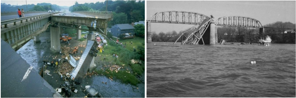
Slika 20.: a) Kolaps mosta Mianus River (Izvor: [21]); b) Kolaps mosta Silver Bridge (Izvor: [22])
