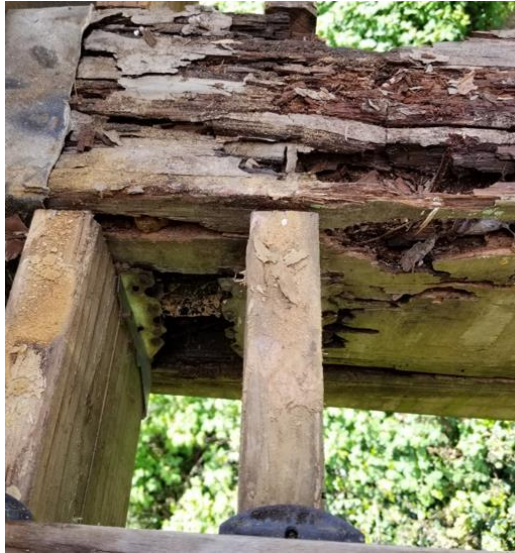
Slika 21.: Truljenje drva (Izvor: [9])
