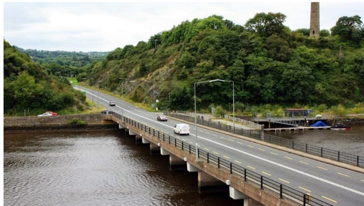
Slika 17.: Ferrycarrig Bridge (Izvor: [20])
