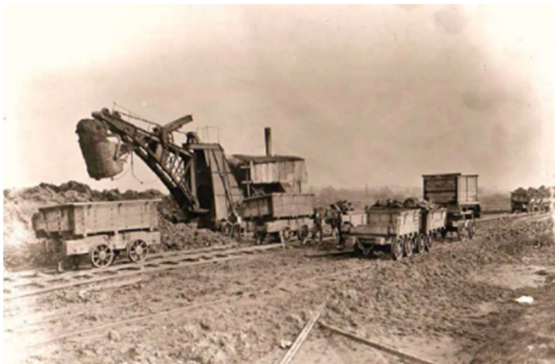
Slika 37: Izgradnja željezničke pruge pomoću kočija i parnog bagera (Izvor: [12])
