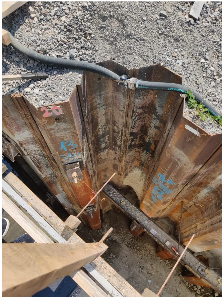
Slika 23 Ugrađene talpe na podvožnjaku "Lazina"
