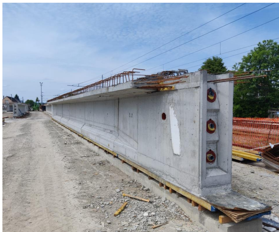
Slika 59 Prikaz predgotovljenih prednapetih nosača "T" oblika
