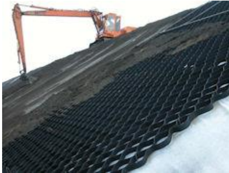
Slika 51 Ugradnja geomreža (Slika preuzeta s [ http://www.geotekstili.com/geosace.asp ])
