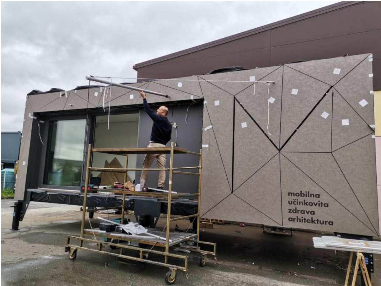
Slika 5.: Vanjska ovojnica i proces izvedbe (Izvor: "The NZEB Roadshow" , projekt MUZA, nZEB galerija)
