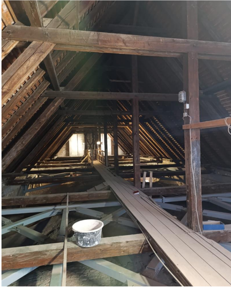
Slika 60. Konstrukcija jednostruke visulje na crkvi
