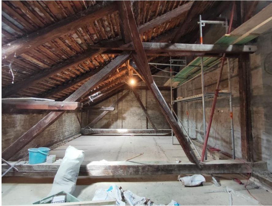
Slika 76. Konstrukcija krovišta u Mrazovićevoj 7
