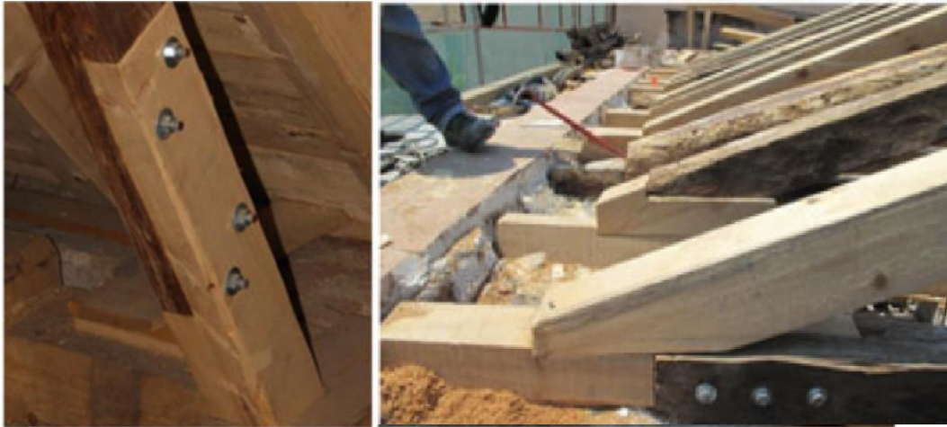
Slika 36. Spoj novog dijela elementa sa starim zdravim dijelom nosivog elementa uz ojačanje navojnim šipkama [12]
