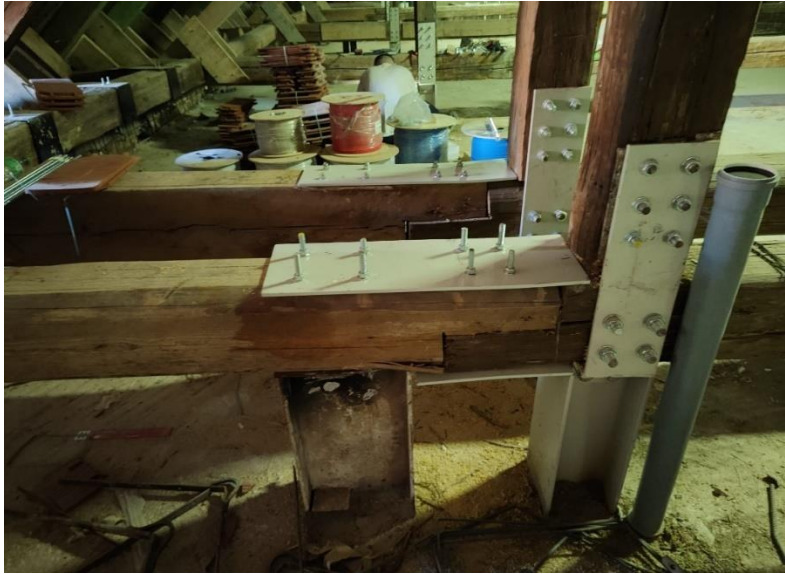
Slika 48. Ojačanje spoja novog sa starim dijelom vezne grede
