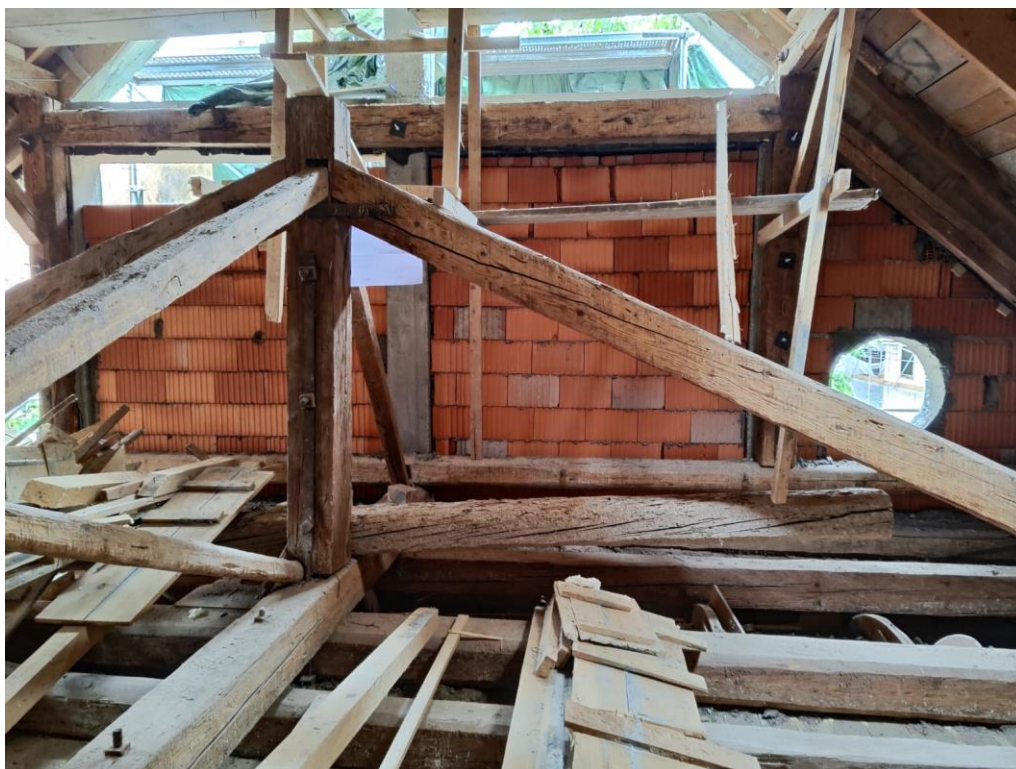
Slika 46. Gradnja novog zabatnog zida
