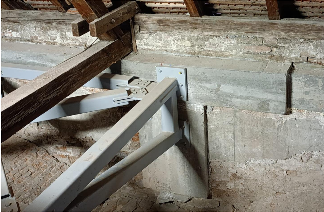
Slika 65. Spoj konstrukcije navojnim šipkama kroz serklaže
