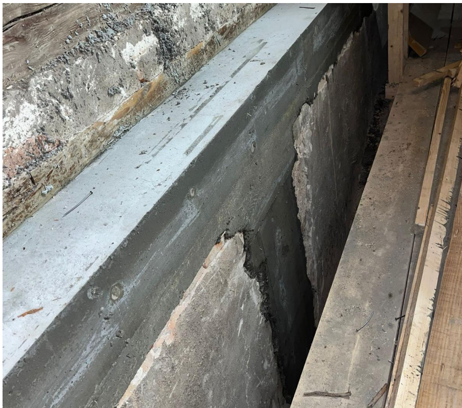
Slika 62. Spoj vertikalnog sa horizontalnim serklažem
