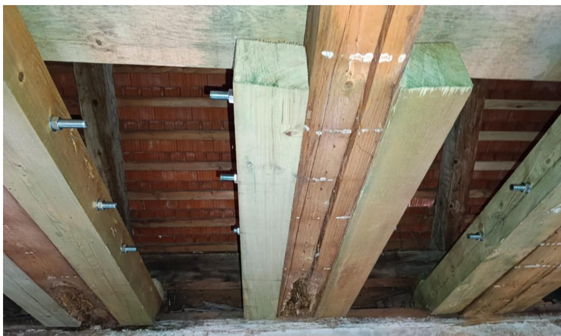
Slika 68. Proteze od novih greda uz trošne grede obostrano
