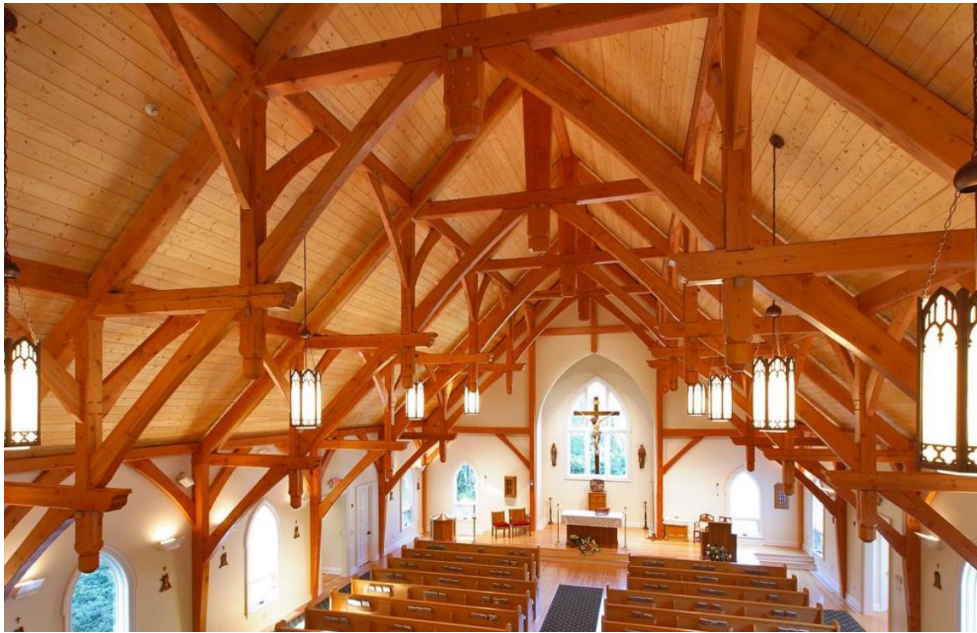
Slika 18. Primjer krovšta sa konzolnim nosačima - St. Patrick Church, Redding, SAD [7]
