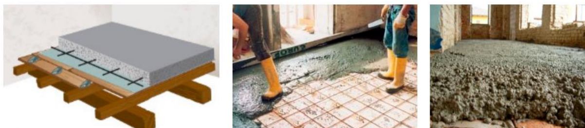
Slika 30. Ugradnja betonske ploče preko veznih greda objekta [14]
