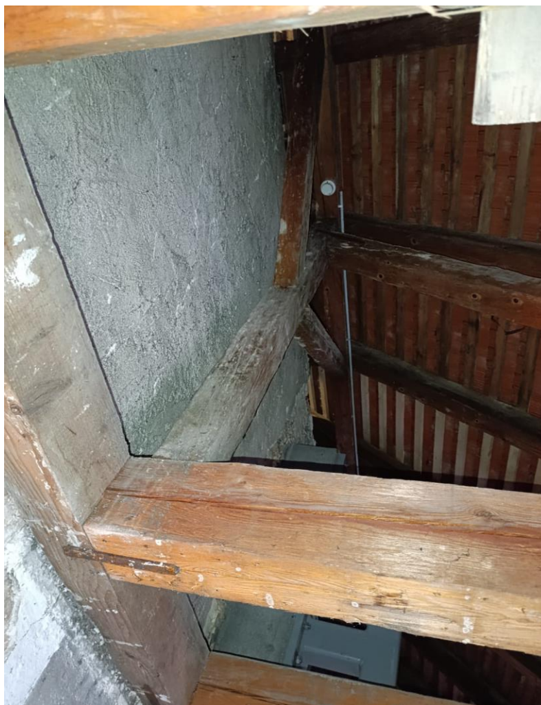
Slika 61. Konstrukcija stolice malih bočnih krovišta
