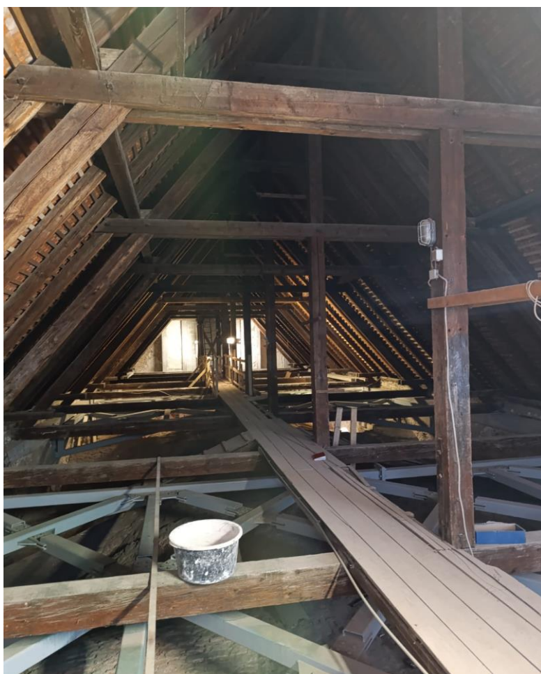
Slika 60. Konstrukcija jednostruke visulje na crkvi
