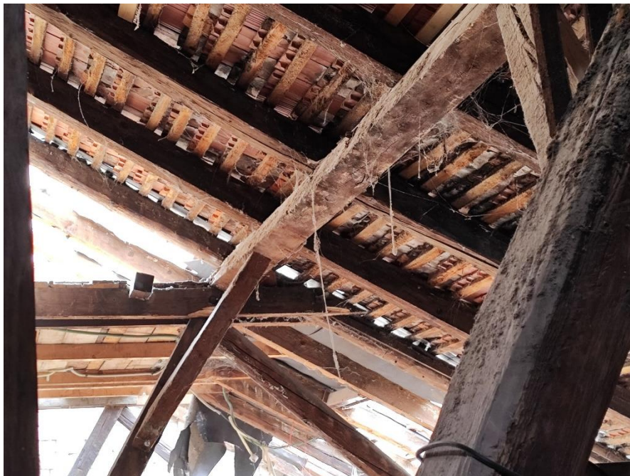
Slika 77. Kosi stupovi konstrukcije krovišta
