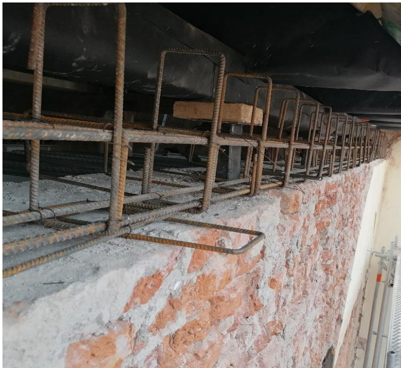
Slika 47. Armiranje horizontalnog serklaža oko drvene grede nazidnice
