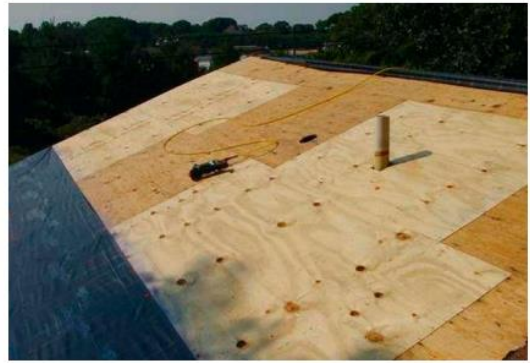
Slika 25. Zakucavanje drvenih i CLT ploča na rogove krovišta [14]
