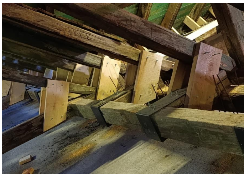
Slika 49. Ojačanje čeličnim "U" profilima (crni metal) i drvenim fosnama
