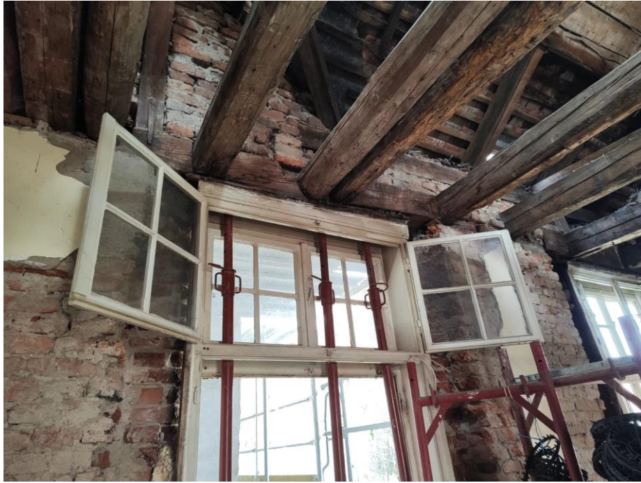
Slika 72. Drveni nadvoj o koji se oslanjaju grede konstrukcije krovišta
