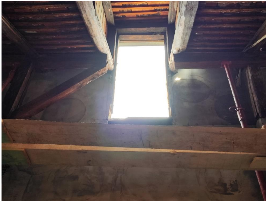
Slika 78. Otvor za ulaz na ravni krov
