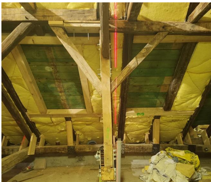
Slika 56. Rezanje rogova za postavu krovnih prozora
