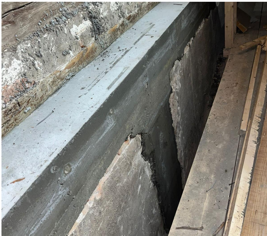
Slika 62. Spoj vertikalnog sa horizontalnim serklažem
