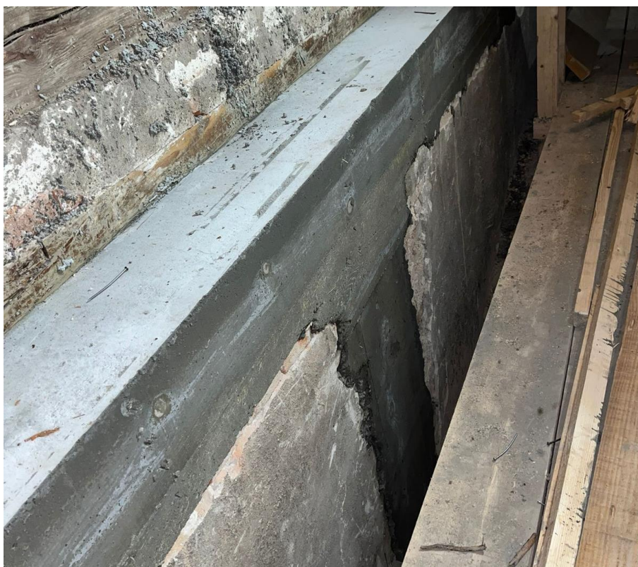
Slika 62. Spoj vertikalnog sa horizontalnim serklažem
