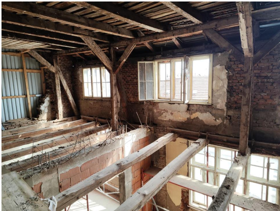
Slika 74. Konstrukcija krovišta sa ulične strane
