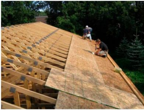
Slika 25. Zakucavanje drvenih i CLT ploča na rogove krovišta [14]
