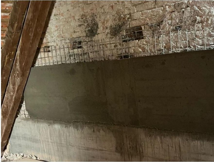
Slika 66. Betoniranje zabatnog zida
