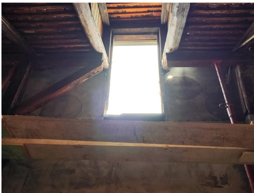
Slika 78. Otvor za ulaz na ravni krov
