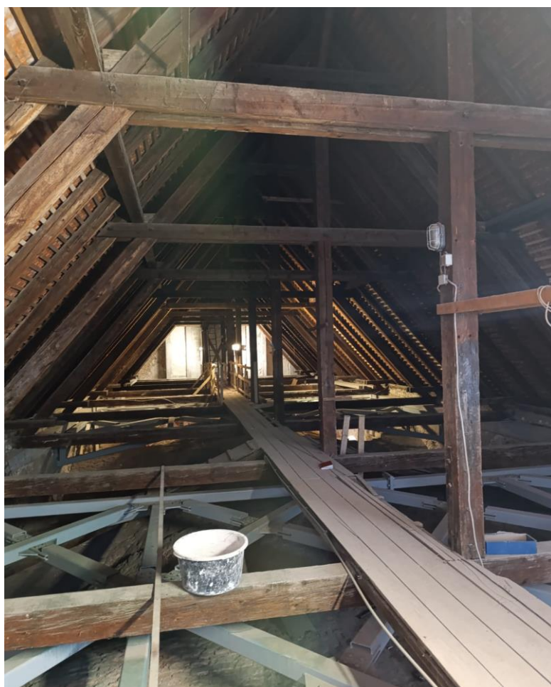
Slika 60. Konstrukcija jednostruke visulje na crkvi
