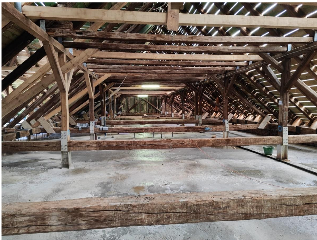
Slika 54. Izbetonirana AB ploča potkrovlja
