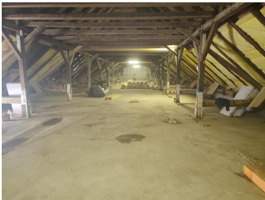
Slika 55. Odsječene vezne grede konstrukcije krovišta
