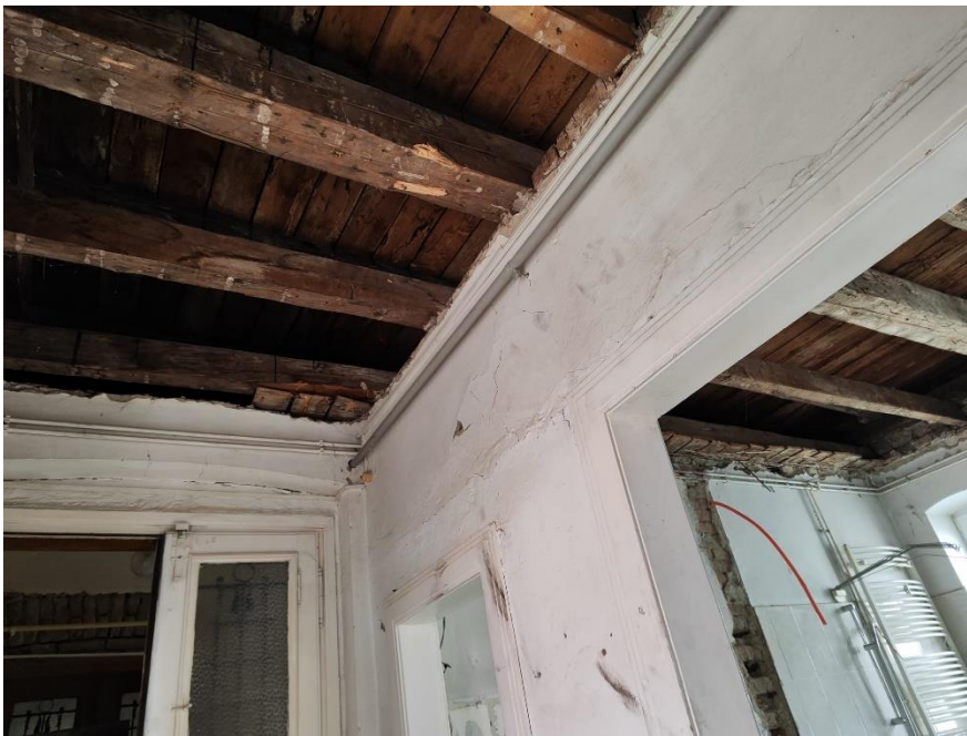
Slika 75. Oslanjanje ravnog krova preko drvenih greda
