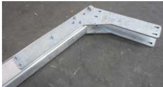
Slika 7: Priključci prečka - stup s čeličnim pločama [5]
