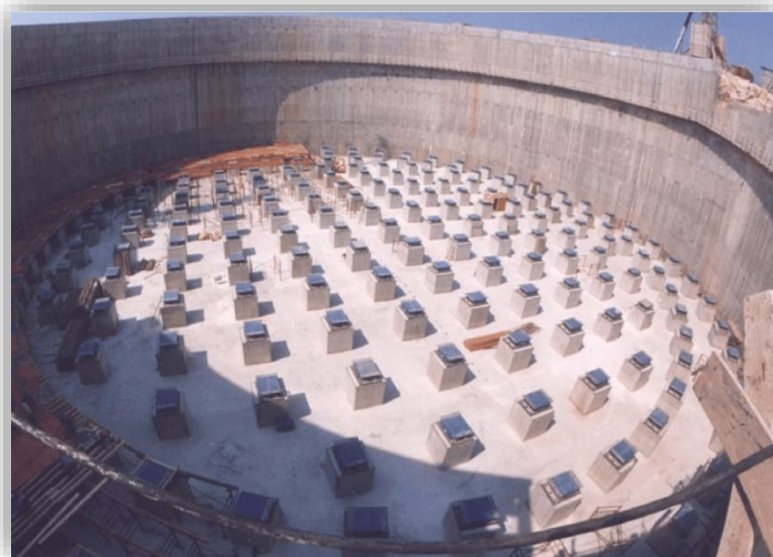
Slika 2.7 Prikaz ležajeva spremnika za ukapljeni plin (LNG - liquefied natural gas) na otoku Revinthosa u Grčkoj tijekom gradnje (Christovasilis, 2006.)
