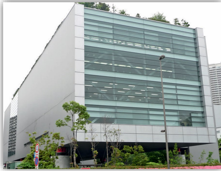
Slika 2.19 Glavna zgrada Shimizu Corporation Institute of Technology u Tokyo-u izolirana sa 6 olovno-gumenih ležajeva (Charleson, Guisasola, 2017).
