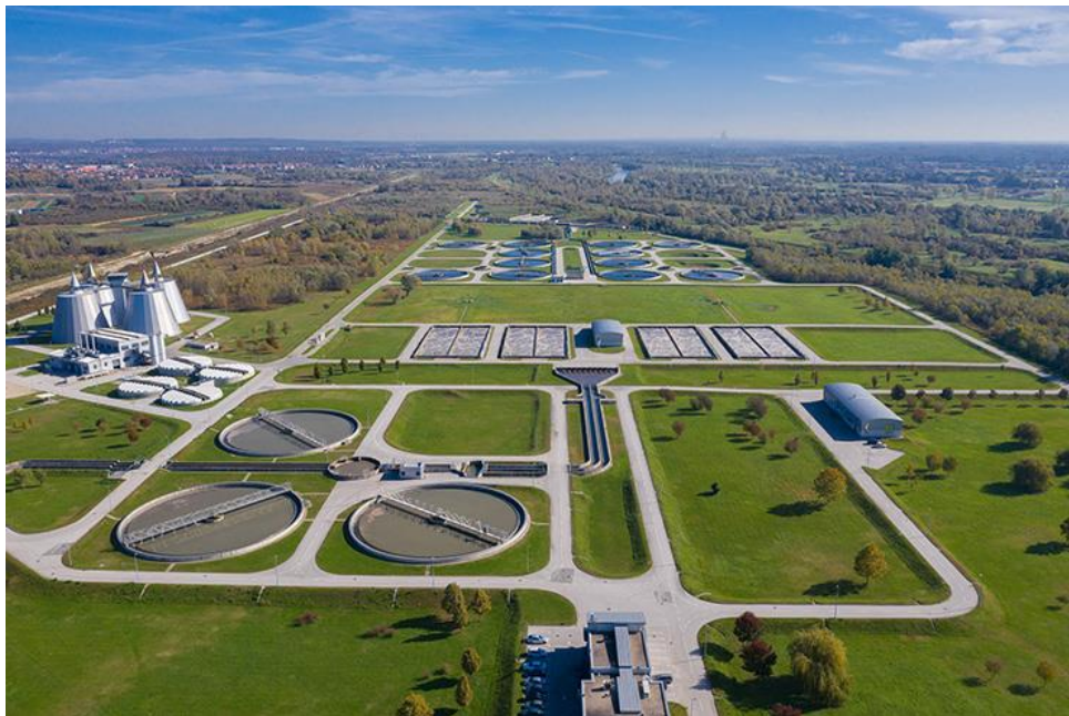
Slika 29: Centralni uređaj za pročišćavanje otpadnih voda grada Zagreba (Izvor: [27])
