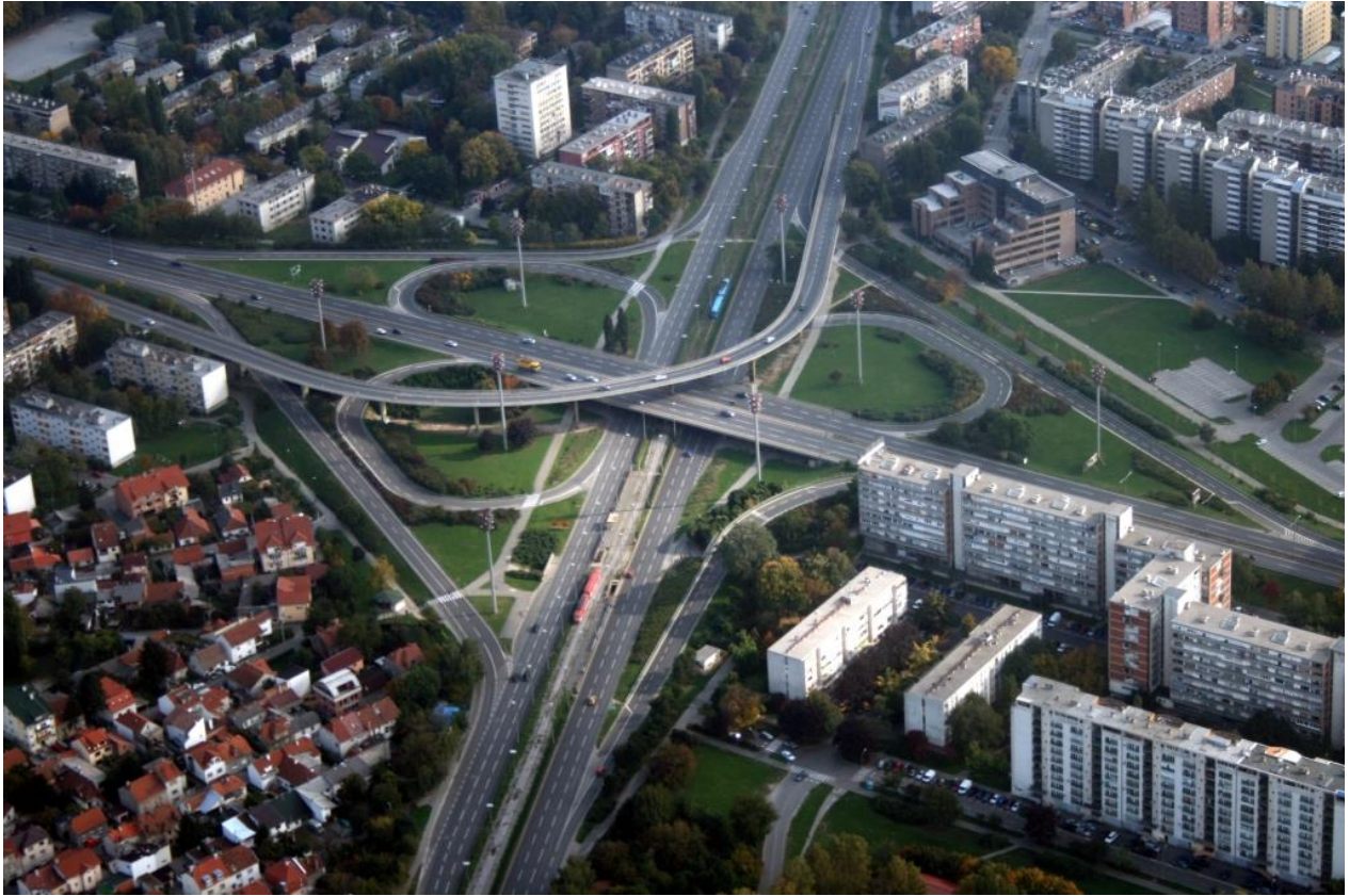
Slika 22: Petlja, prometno raskrižje Slavonske avenije i Držićeve
