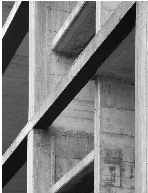
Slika 4.1. Prostorni gredni nosač [6]
