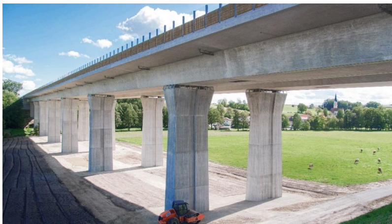
Slika 4.2. Primjena kod mostova, Ornatalbrücke, Njemačka [5]
