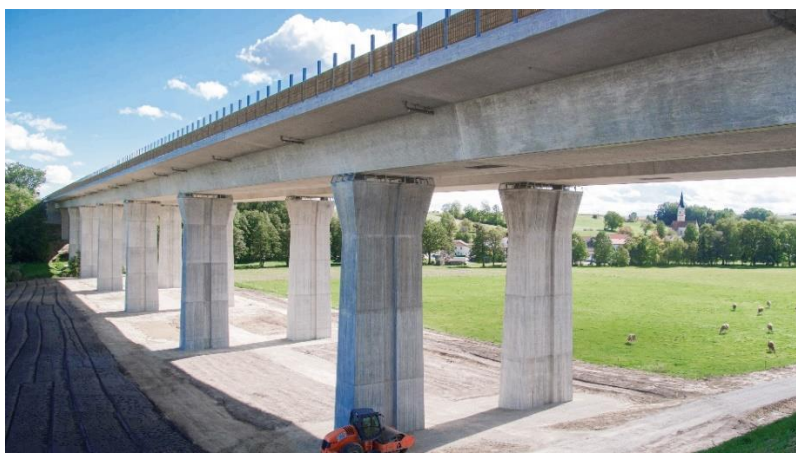
Slika 4.2. Primjena kod mostova, Ornatalbrücke, Njemačka [5]
