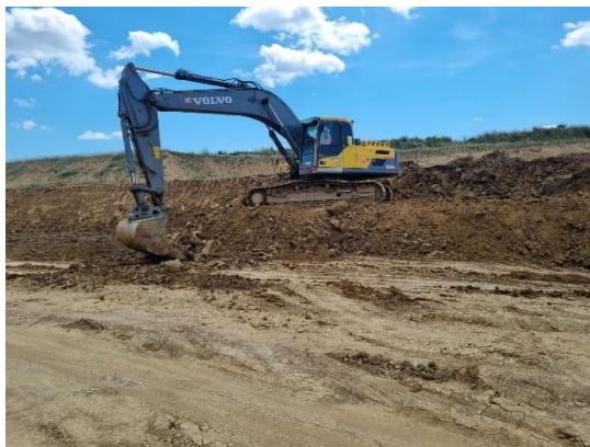
Slika 6. Strojni iskop gline (Izvor: [11])
