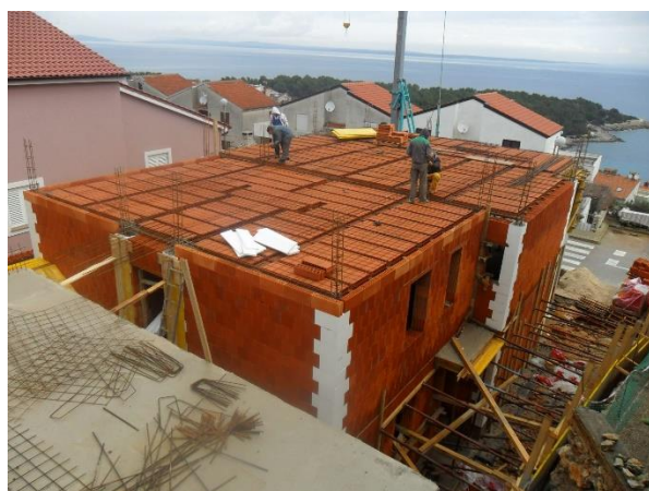
Slika 33. Izrađeni Potorherm stropni sistem (Izvor: [38])
