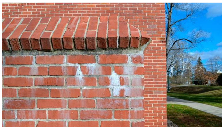
Slika 11. Iscvjetavanje na površini opeke (Izvor: [15])
