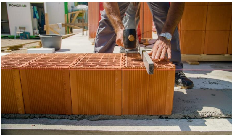
Slika 25. Zidanje prvog reda (Izvor: [29])
