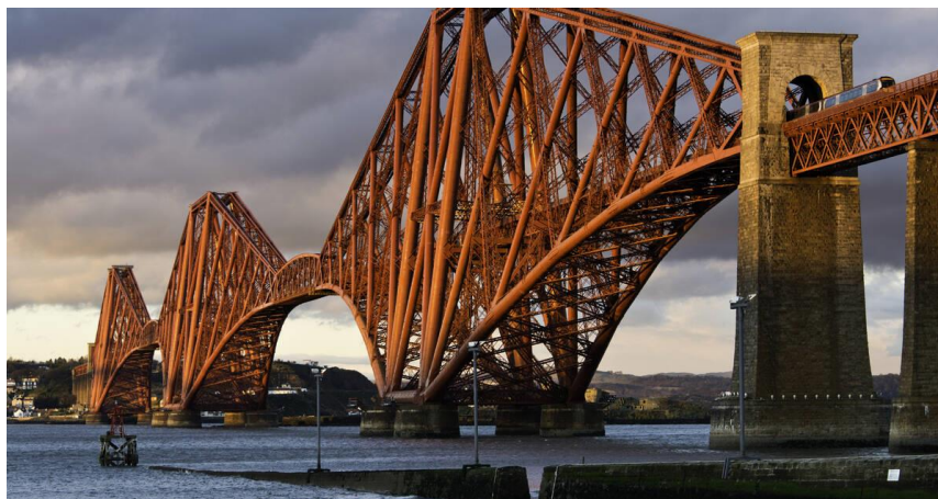
Slika 4.1. Most Forth u Škotskoj [11]
