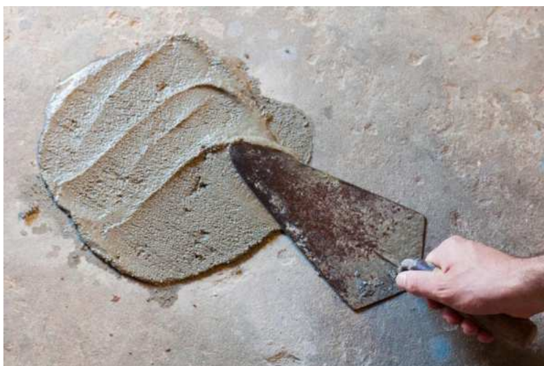
Slika 22.: Krpanje cementom [22]
