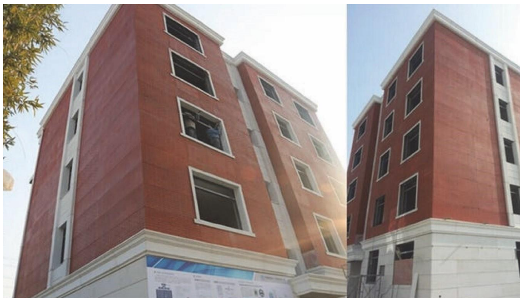
Slika 22.: Prva stambena zgrada na svijetu izgrađena pomoću 3D printanja u Kini [19]
