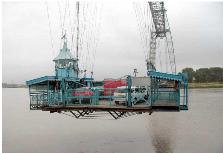
Slika 58.: Gondola Newportskog prijevoznog mosta [33]
