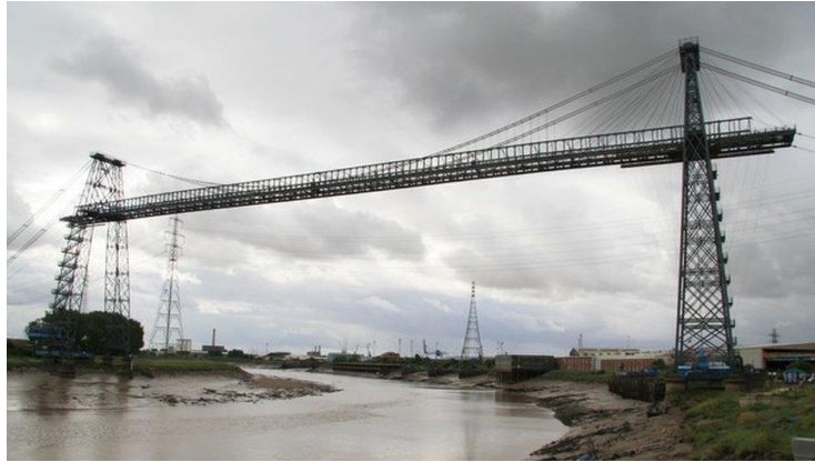
Slika 57.: Prijevozni most u Newportu, Wales [33]
