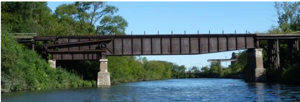
Slika 17.: Zapadni željeznički most, Chicago [15]
