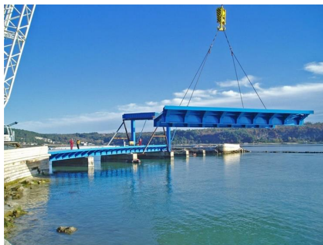
Slika 55.: Rekonstrukcija mosta Antenal, Novigrad [35]
