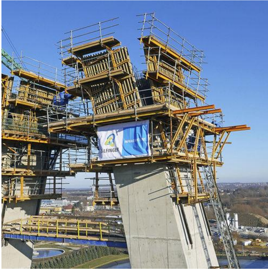
Slika 36: Penjajuća oplata stupova mosta (Izvor [33.]
