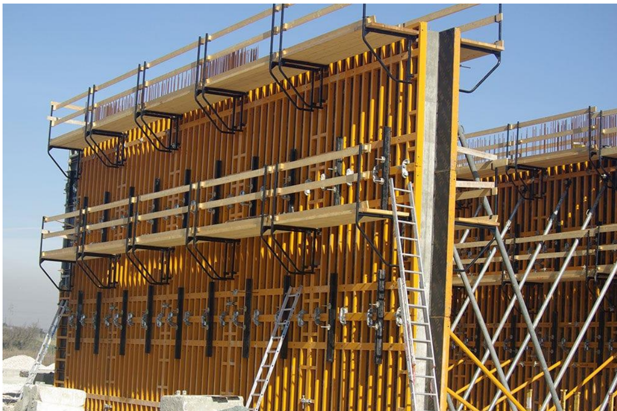
Slika 49: Primjer čeline oplata zida (Izvor [47.]
