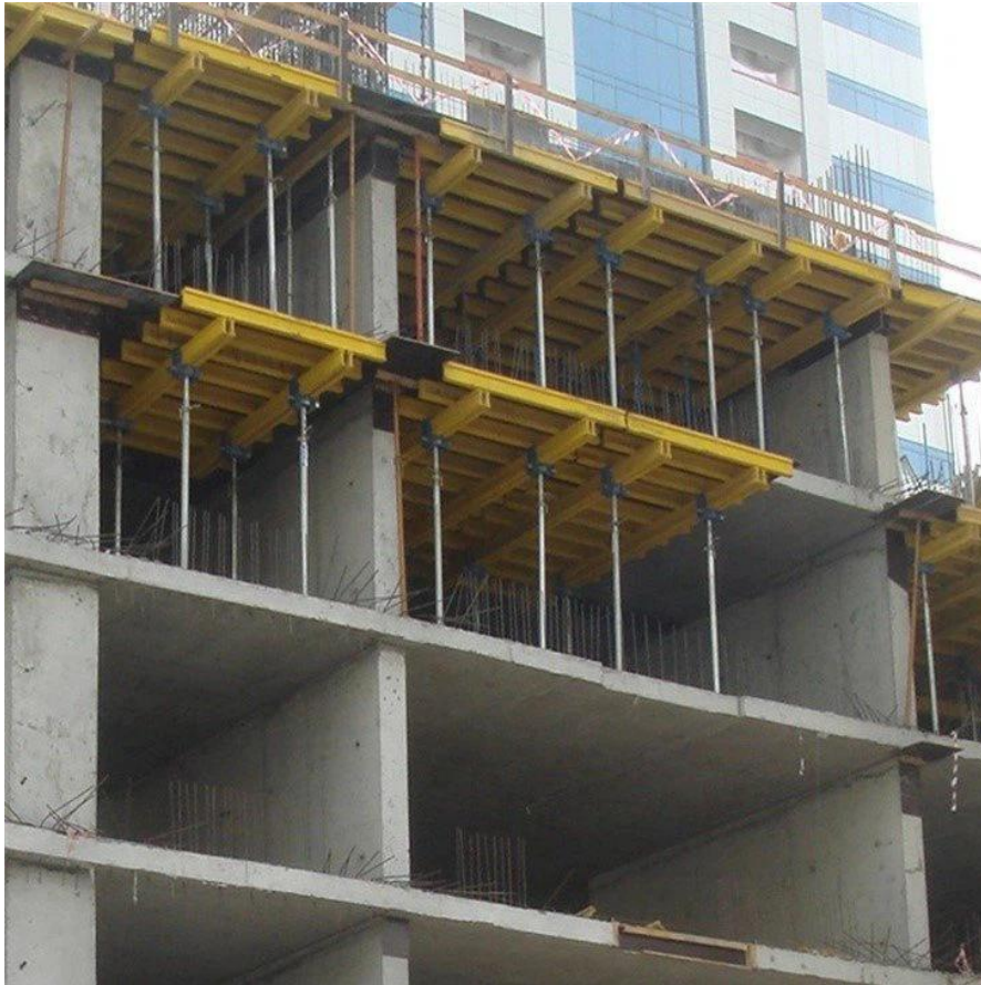
Slika 51: Oplata ploče (izvor [48.])
