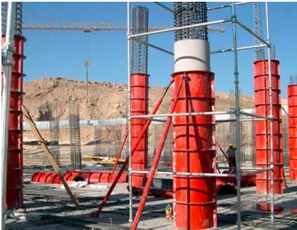
Slika 50: Čelična oplata stupa (Izvor [43.]
