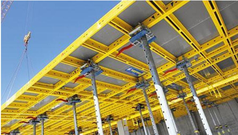
Slika 44: Čelični podupirači (Izvor [43.])
