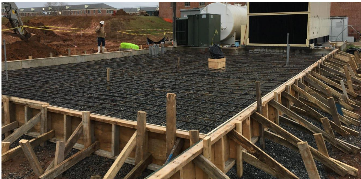
Slika 48: Drvena oplata temeljne ploče (Izvor [46.])
