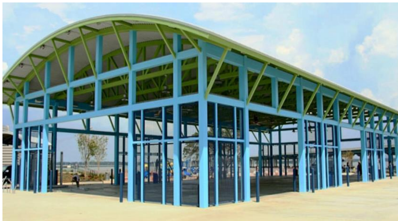
Slika 18.: Primjer čelične konstrukcije zaštićene duplesnim sustavom (Izvor:[6])
