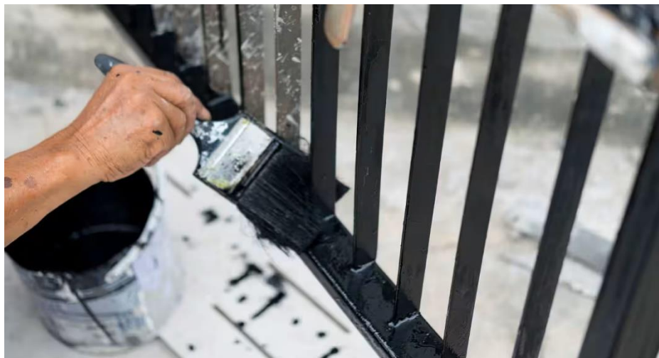
Slika 10.: Nanošenje zaštite boje kistom (Izvor: [32])
