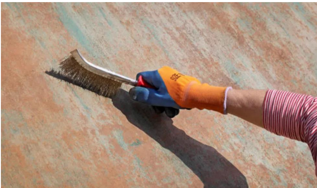
Slika 4.: Primjer čišćenja ručnom četkom (Izvor: [30])
