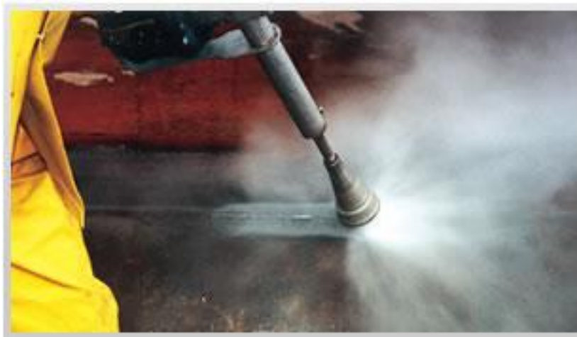
Slika 7.: Čišćenje vodenim mlazom ultra visokog pritiska (Izvor: [29])
