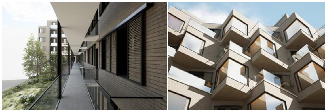
Slika 3.3. Detalj vanjskih prolaza između stanova na južnoj i istaka zidova na sjevernoj strani
