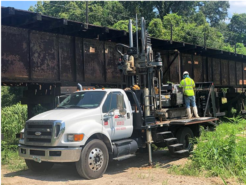
Slika 37. Oprema za CPT-teško vozilo [27]
