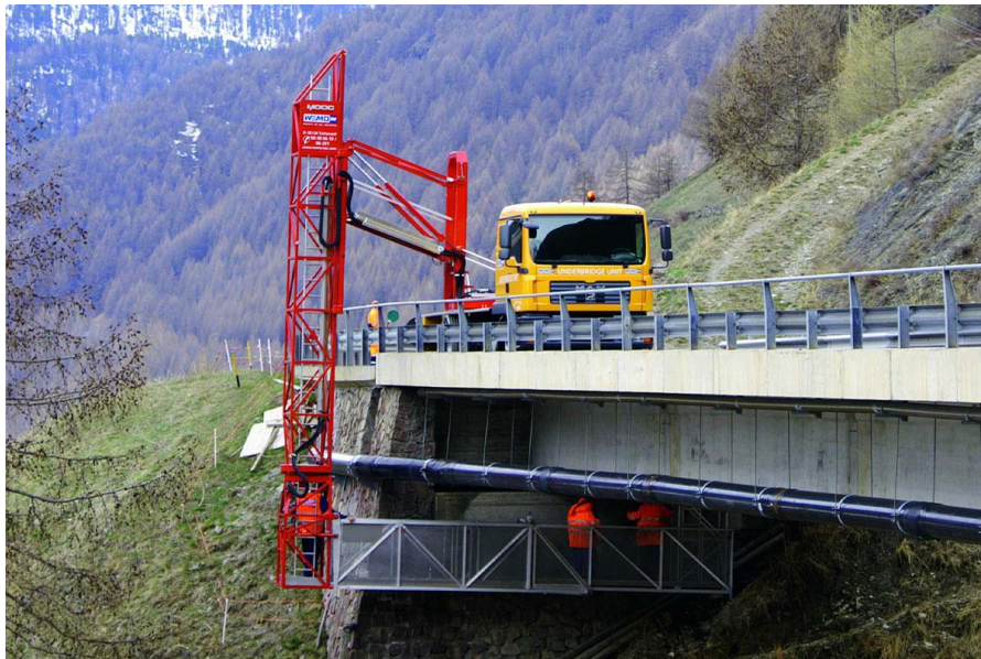
Slika 7. Suvremeno vozilo za pregled rasponske konstrukcije negativno utječe na odvijanje prometa preko mosta (11)
