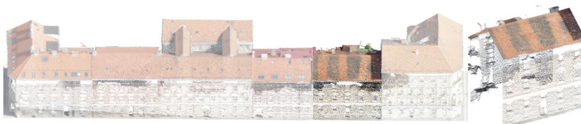
Slika 65. Položaj zgrade u bloku na adresi Šenoa 25
