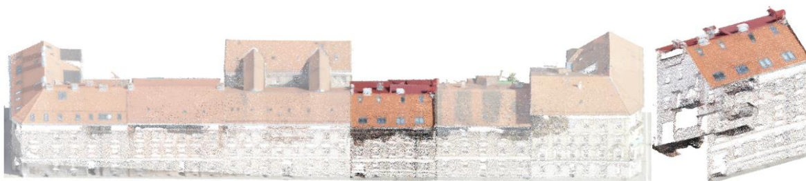
Slika 63. Položaj zgrade u bloku na adresi Šenoa 23
