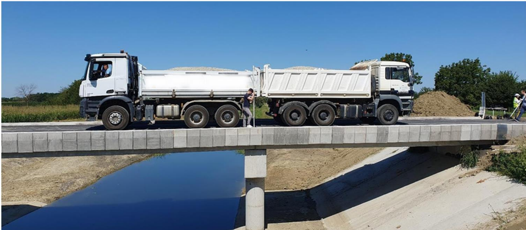
Slika 67.: Statičko ispitivanje mosta kamionima – mjerenje vertikalnih pomaka u FAZAMA
