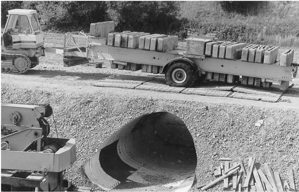
Slika 21.: Specijalno jednoosno priključno vozilo za vrijeme ispitivanja odvodnog kanala
