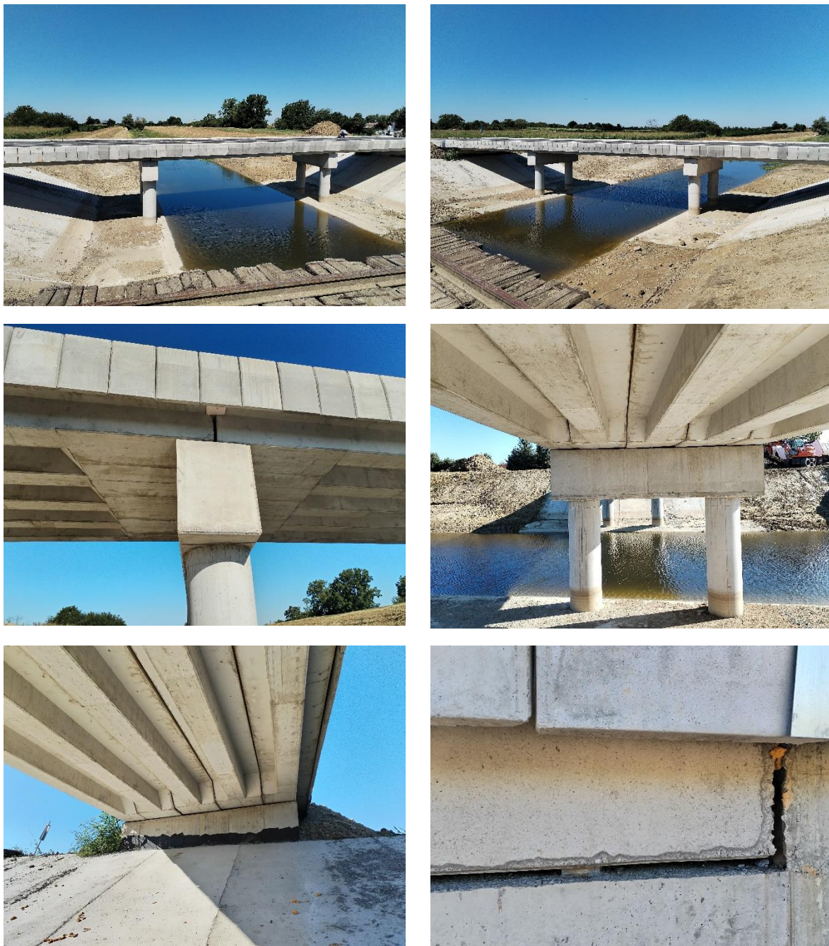
Slika 27.: Fotodokumentacija predmetnog mosta
