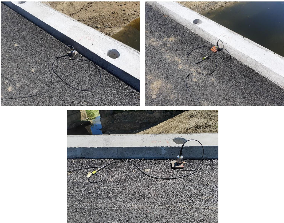
Slika 68.: Akcelerometri za dinamičko ispitivanje mosta
