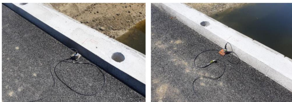
Slika 28.: Akcelerometri za dinamičko ispitivanje mosta
