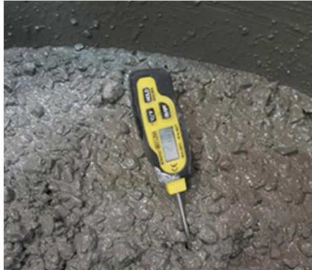
Slika 9. Mjerenje temperature svježeg betona termometrom
